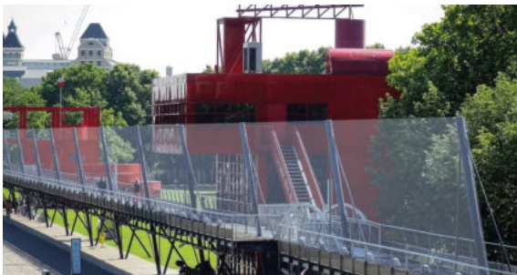
FIGURA 2.29: Fijación con tubos cilíndricos
