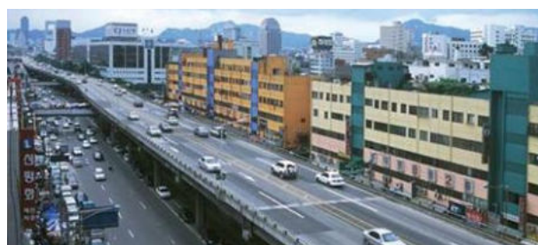
FIGURA 2.42: Autopista. Fuente:(Karzulovic, 2008) https://bit.ly/3V6EESG
