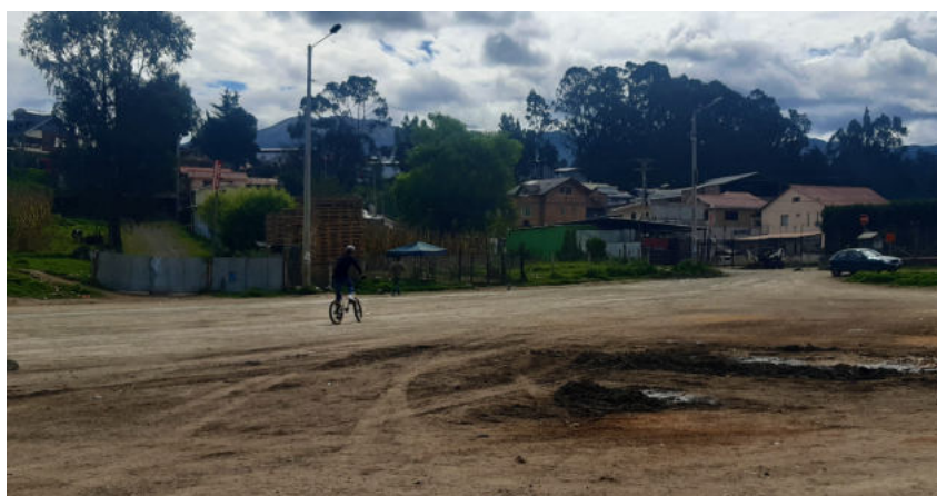
FIGURA 3.28: Deterioro del suelo. Fuente: Fotografía tomada por el autor
