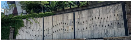
FIGURA 2.62: Paneles de madera
