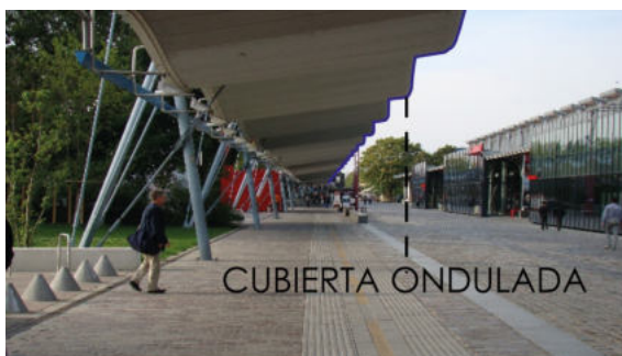
FIGURA 2.35: Estructura metálica – cubierta
