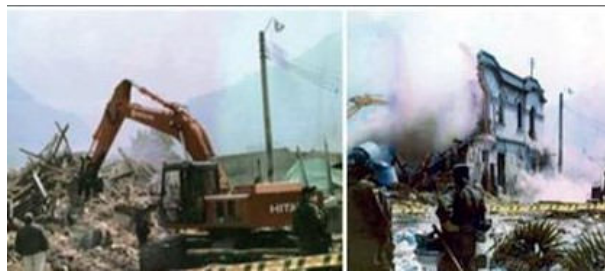
FIGURA 2.102: Demolición del barrio. Fuente: (Martínez, 2012) https://bit.ly/3MVoZDQ
