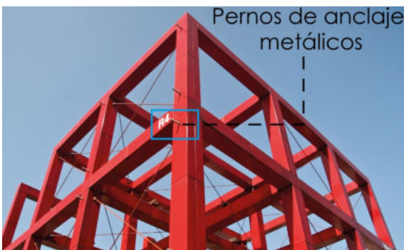
FIGURA 2.30: Uniones metálicas
