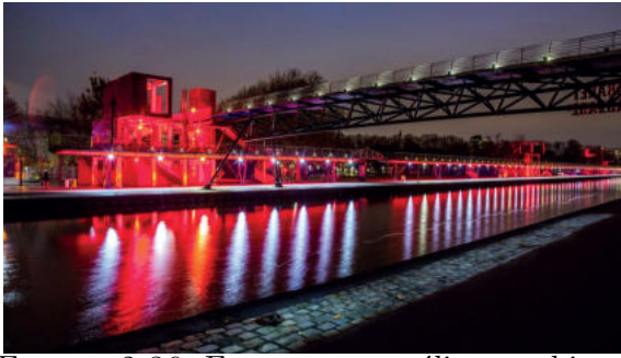
FIGURA 2.36: Estructura metálica – cubierta
