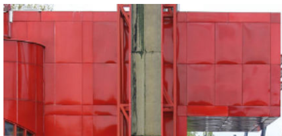
FIGURA 2.26: Fachadas metálicas de color rojo.
