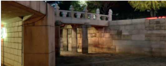
FIGURA 2.56: Columnas de piedra
