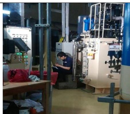
**Foto 8:** Técnicos realizando la revisión de conexiones, cables, terminales y la identificación de equipos eléctricos.
