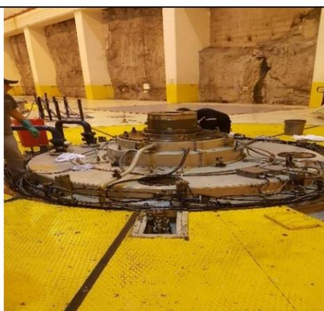
**Foto 9:** Revisión del estado general del anillo magnético ante la presencia de polvo, aceite u objetos extraños.
