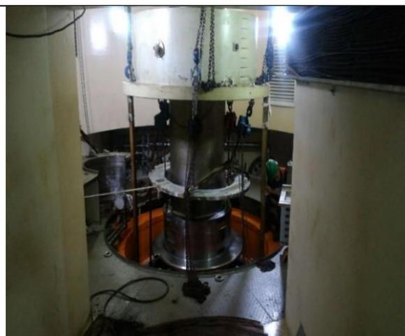
**Foto 12:** Revisiones del estado general del anillo magnético ante la presencia de polvo, aceite u objetos extraños en el interior.
