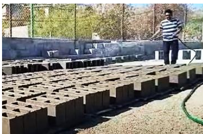
Curado de bloque en fábrica
