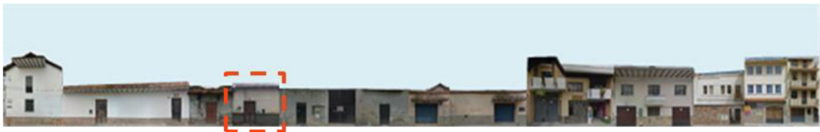
FIGURA 2.7: Tramo de la calle Alfonso Jerves. Fuente. Google Earth Año 2018. Elaboración. Francisco Piedra
