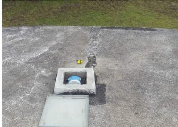
**Figura 35.** Ubicación del sensor Prosonic-M FMU41
