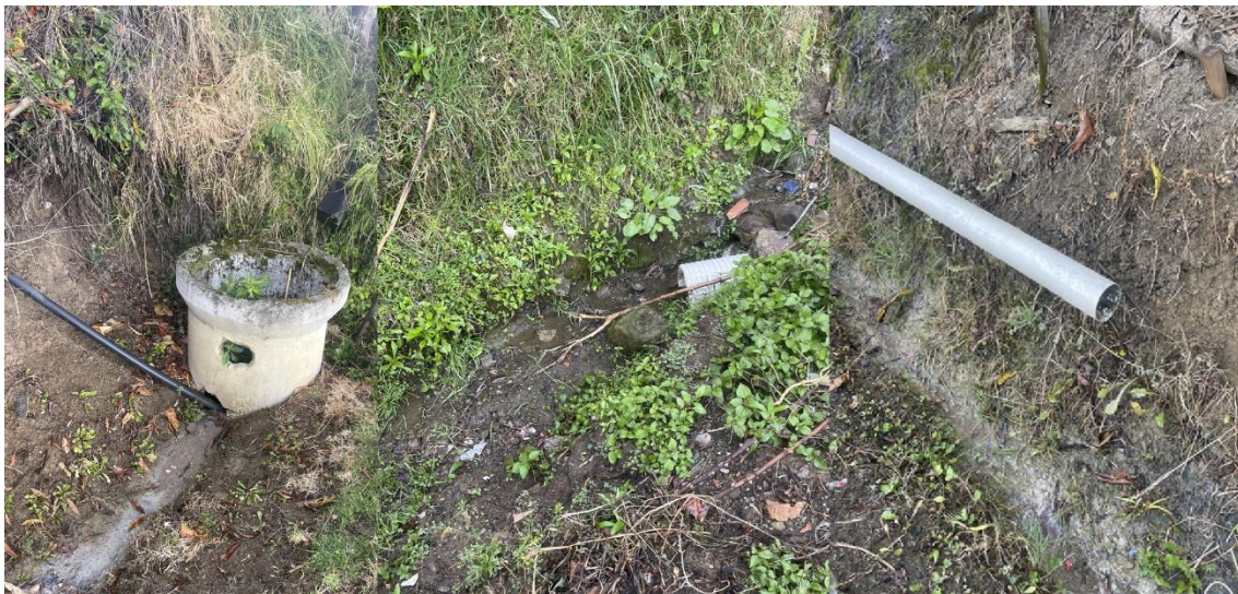
Figura 3-9. Puntos de descarga directa de agua domiciliar en la zona de estudio
