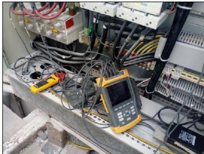
Fig. 7. 1 Adquisición de datos por medio de analizador y amperímetro
