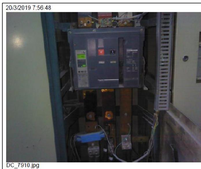
Fig. 7. 57 Protección principal de tablero de transformador. No.1 donde se adquirió el valor de temperatura
