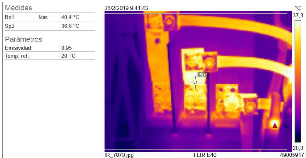
Fig. 7. 55 Foto de termografía en las tres fases del tablero de chiller y compresores
