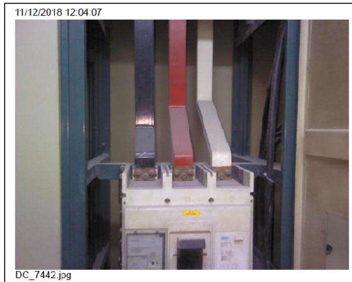
Fig. 7. 50 Protección principal de tablero de inyectoras donde se adquirió el valor de temperatura
