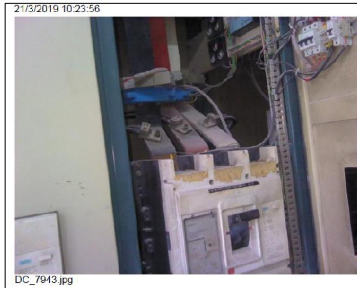
Fig. 7. 60 Protección principal de tablero de transformador No.2 donde se adquirió el valor de temperatura
