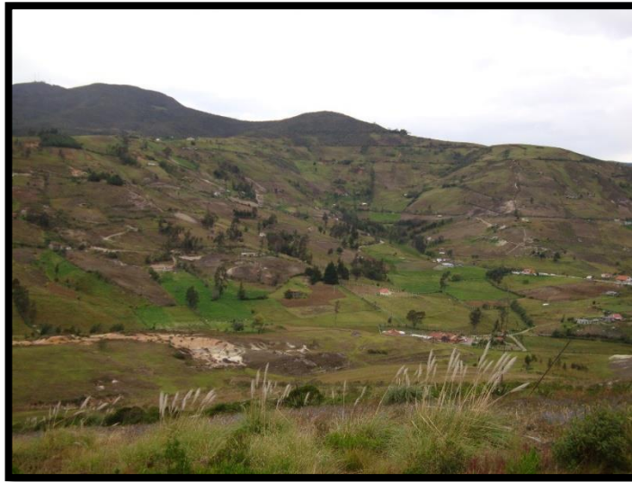
Zona donde se colocara la tubería de conducción
