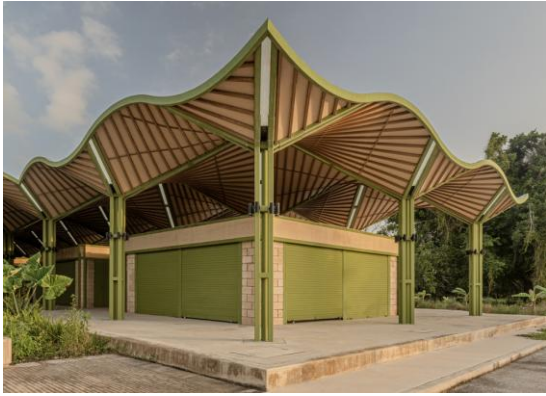
Figura 49. Vista frontal de la cubierta reticular.
