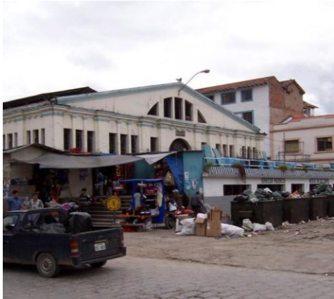
Figura 15. Exterior del Mercado 9 de Octubre (Previo a Reforma).
