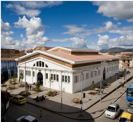
Figura 17. Interior del Mercado 9 de Octubre (Previo a Reforma).
