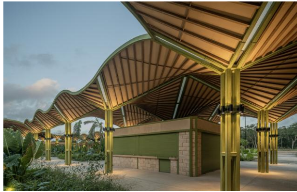
Figura 50. Vista inferior de la cubierta reticular.
