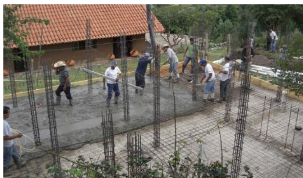
Figura 37: Cimentación de hormigón, debido a tipo de suelo.
