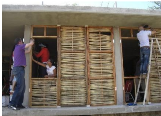
Figura 38: Entramado de carrizo para elaborar los paneles de bahareque
