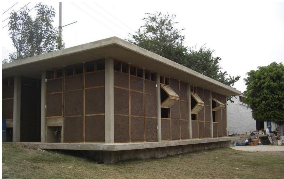
Figura 34: Edificio Comunitario de Muros de Bahareque y Celosía de Carrizo – Guadalajara, México.
