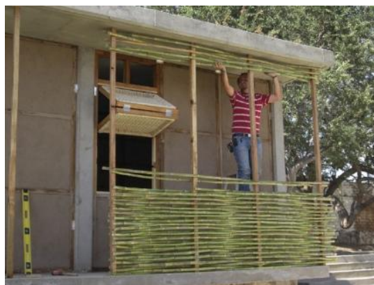
Figura 39: Armado manual de la celosía de caña
