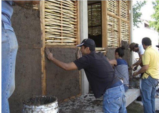
Figura 40: Empañetado al entramado de carrizo
