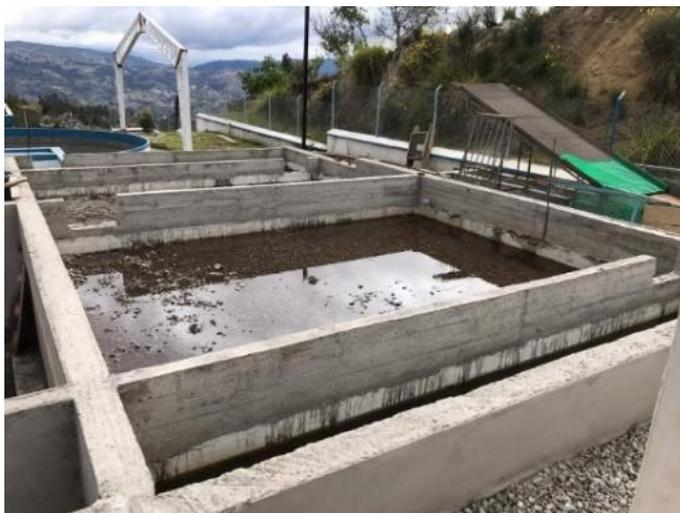
*Imagen 21. Unidades de filtración para tratamiento del agua. – Fuente:(Autor, 2021)*
