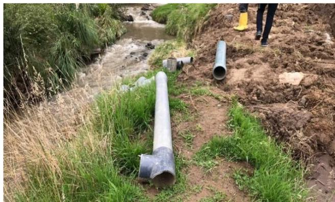
*Imagen 20. Rotura de tubería debido a deslizamiento de tierra. – Fuente:(Autor, 2021)*
