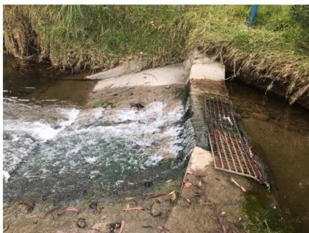
*Imagen 15. Erosión de la pantalla inferior del sistema de captación Pampa Vintimilla. – Fuente:(Autor, 2021)*
