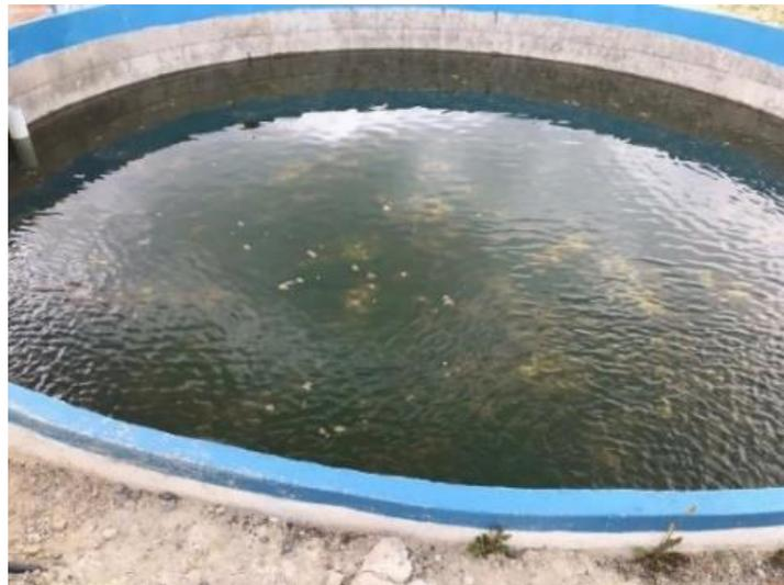
*Imagen 24. Estado del tanque de filtración lenta de la junta Pampa Vintimilla. – Fuente:(Autor, 2021)*
