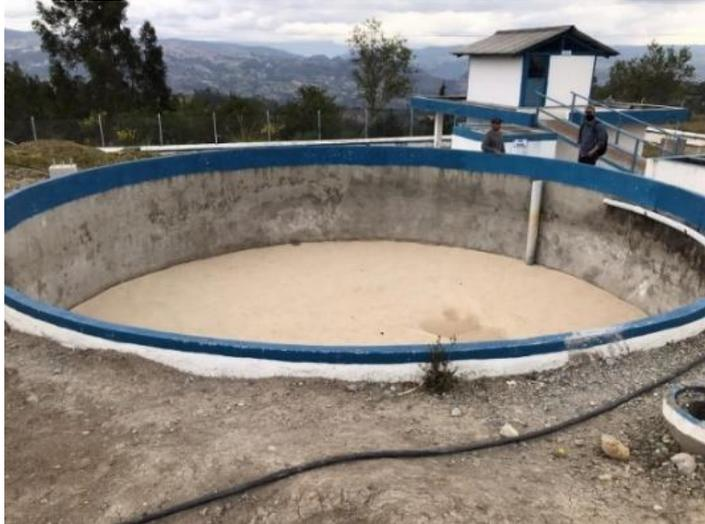
*Imagen 22. Tanque de filtración lenta para tratamiento del agua. – Fuente:(Autor, 2021)*
