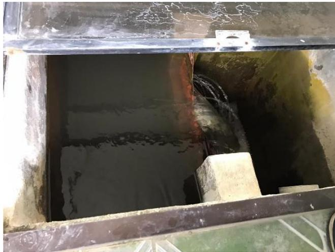
*Imagen 26. Estado la cámara de mezcla rápida de la junta Pampa Vintimilla. – Fuente:(Autor, 2021)*
