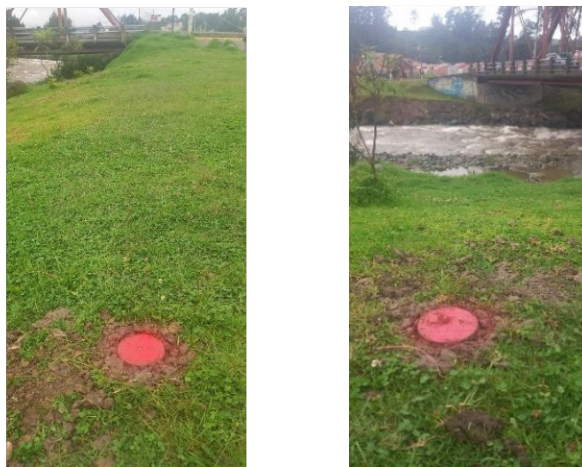
Figura 44. Puntos de referencia para el monitoreo de los estribos del puente.
