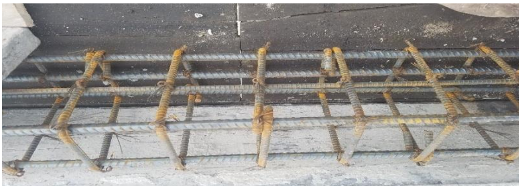
Ilustración 2.11 Acero de refuerzo de una viga.
