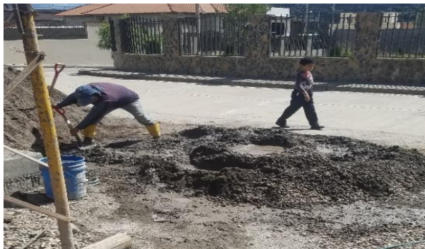
Ilustración 2.2 Mezcla a mano.
