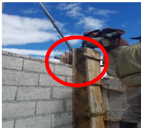
Ilustración 4.7 Compactación de hormigón con una vara de madera.
