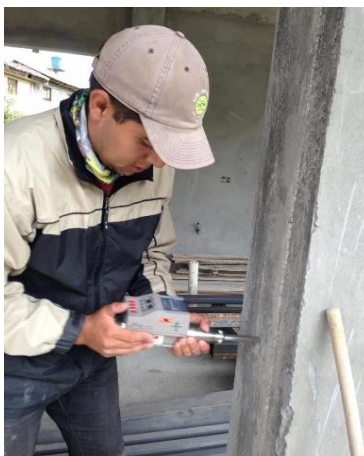
Ilustración 2.10 Ensayo de esclerometría.
