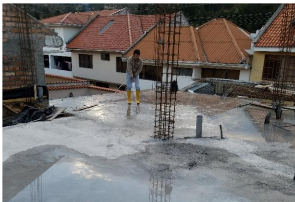
Ilustración 2.7 Curado de losa.
