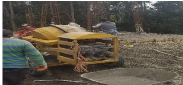
Ilustración 2.3 Mezcla con concretera.
