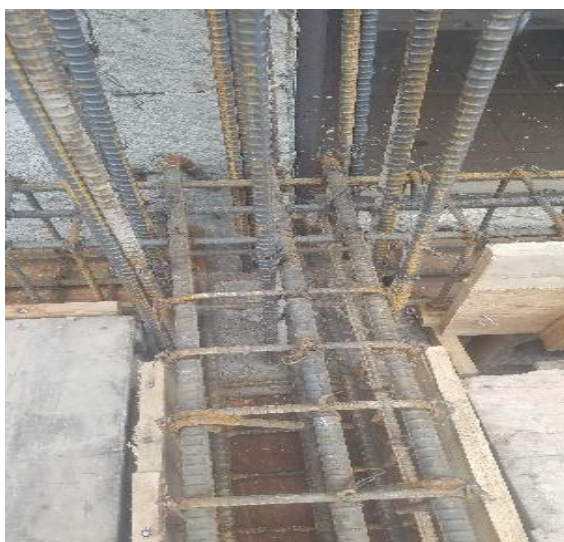
Ilustración 4.2 Acero de refuerzo de vigas
