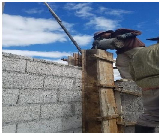
Ilustración 2.5 Colocación de concreto en una columna.
