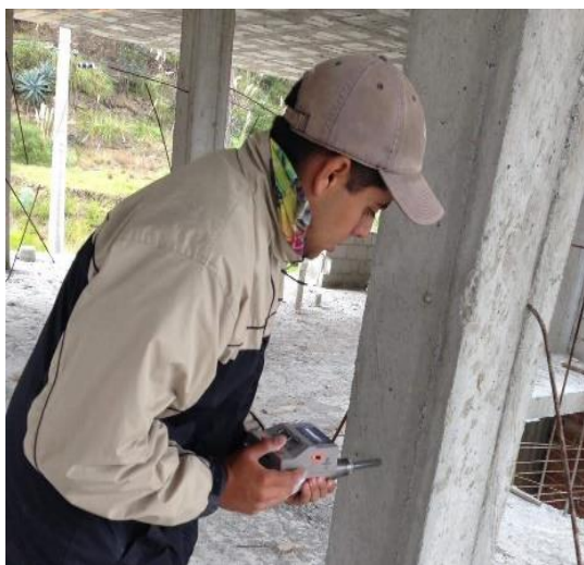
Ilustración 4.11 Ensayo de esclerometría en columna.
