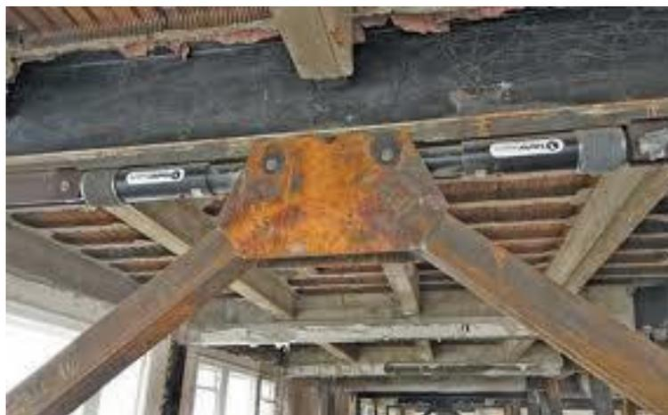
FUENTE: Evaluación del proyecto estructural y optimización del diseño con disipadores de energía viscosos Taylor para una edificación esencial de 6 pisos, 2014).
