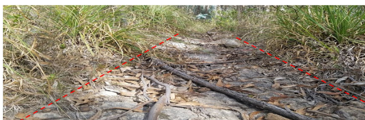
FIGURA 2.11: levantamiento fotográfico del estado actual. Fuente y Elaboración: Propia
