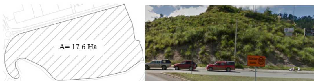
FIGURA 3.20: Topografía accidentada del terreno Rayo Loma
