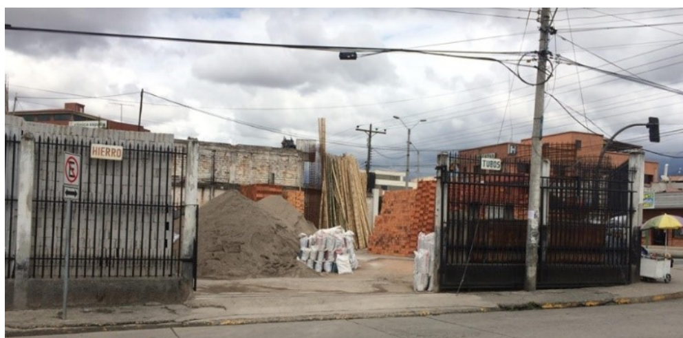
FIGURA 3.11: Presencia de fábrica de ladrillos y bloques
