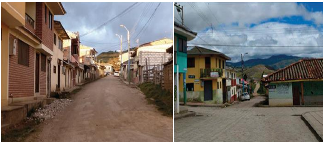
Figura 26: Elementos físicos de las vías.
