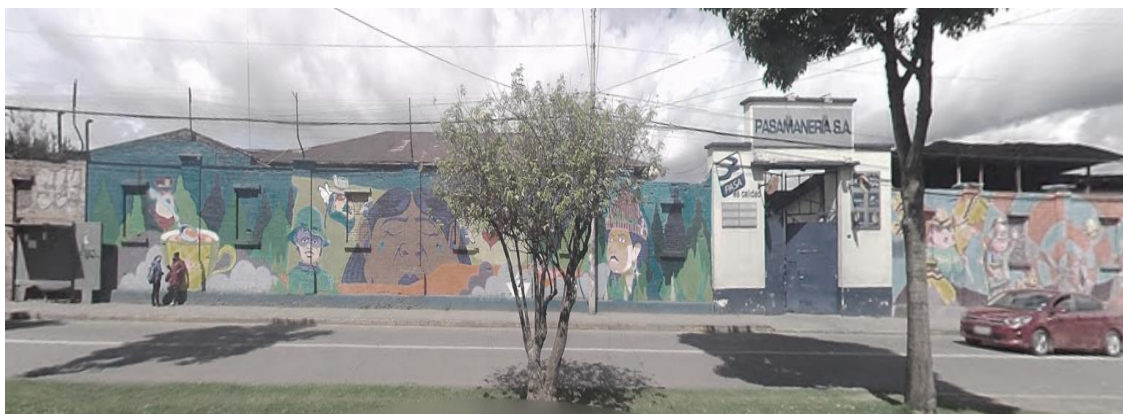
Figura 67: Muro Perimetral de la Fábrica de Pasamanería en el Contexto Urbano.
