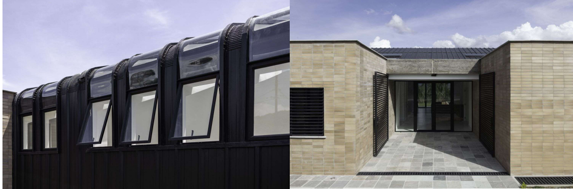
Figura 23: Planchas metálicas negras y mampostería de ladrillo
