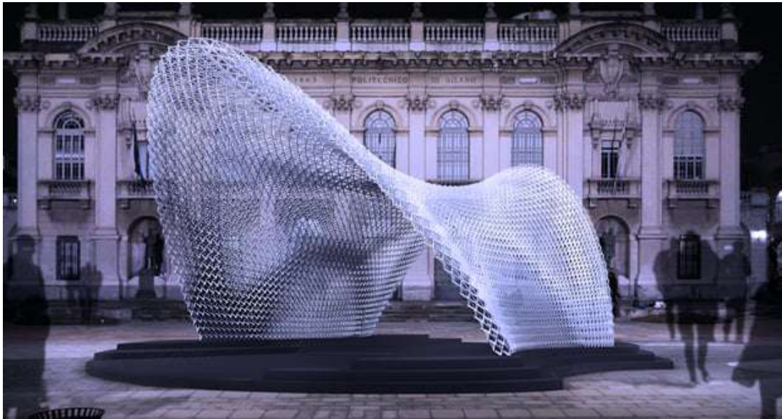
FIGURA 2.6: Trabeculae pavilion, la primera estructura arquitectónica impresa en 3D de milán
