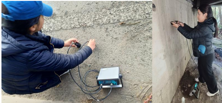
Ilustración 13 Ensayo de ultrasonido en losa y estribo
