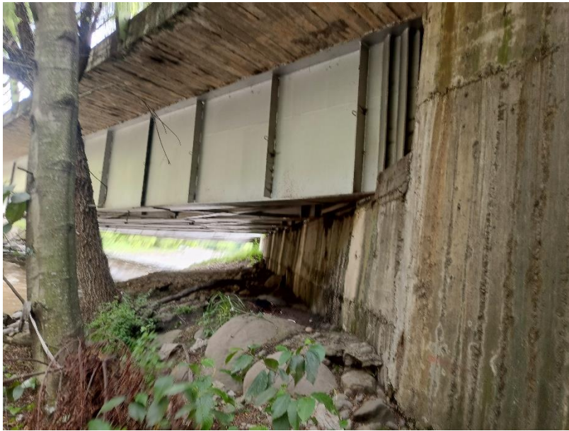
Ilustración 20 Parte baja del puente
