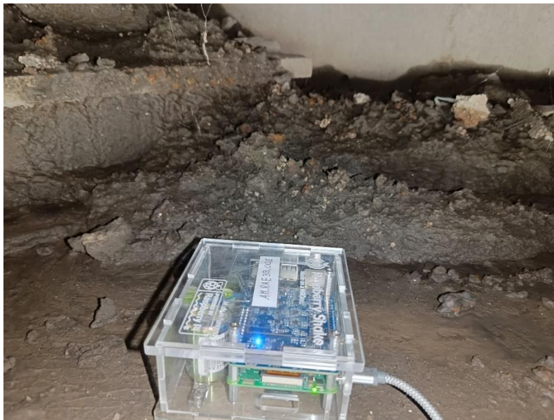
Ilustración 23 Colocación de equipos 2 y3
