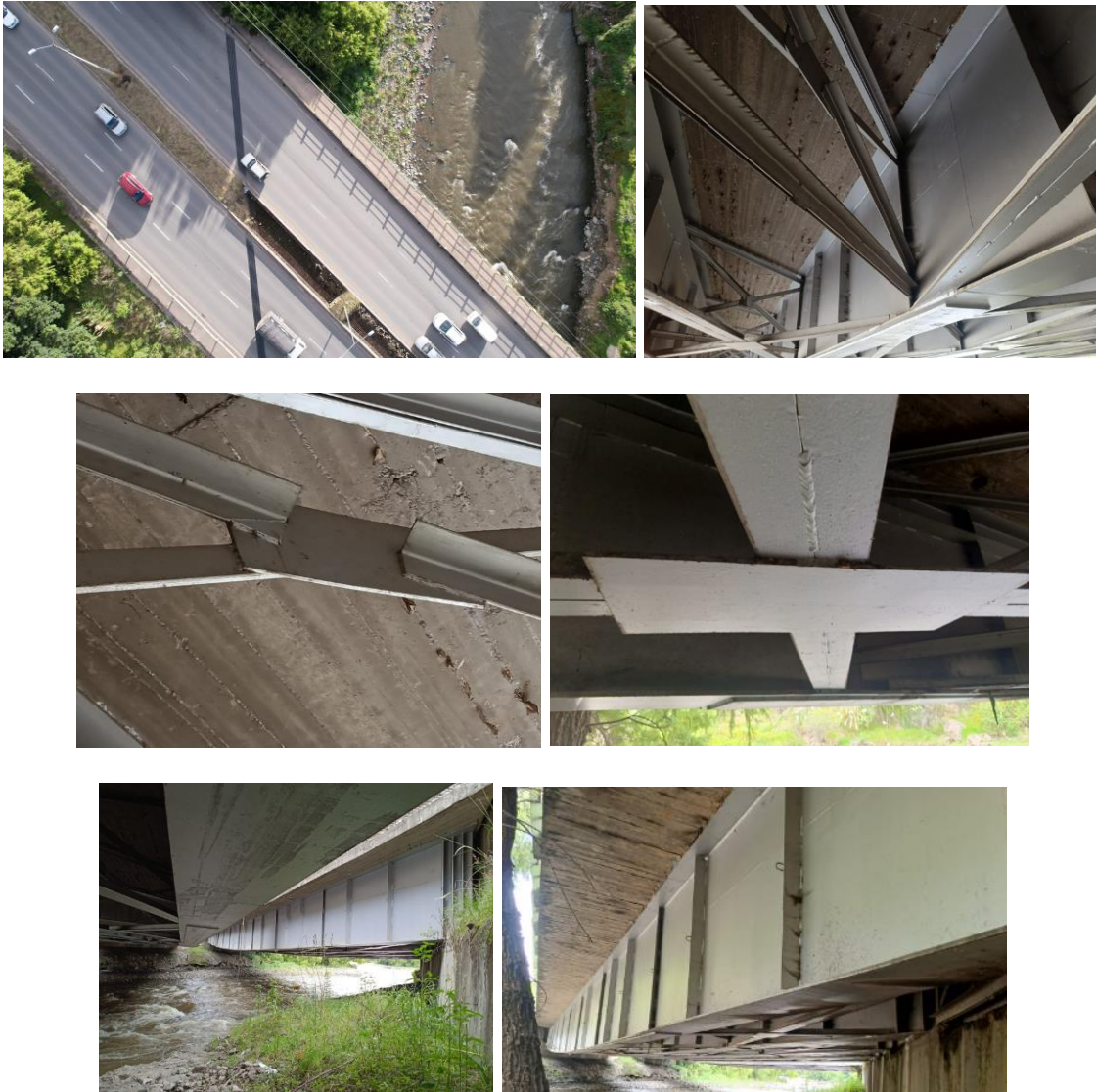
Ilustración 4 Levantamiento fotográfico del puente
