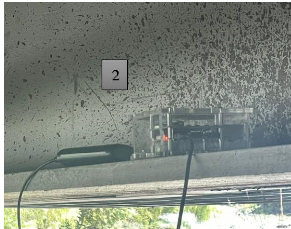
Ilustración 11 Equipo de vibración ambiental conectado en el inicio de la viga
