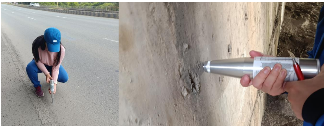
Ilustración 9 Esclerómetro en la losa y estribo
