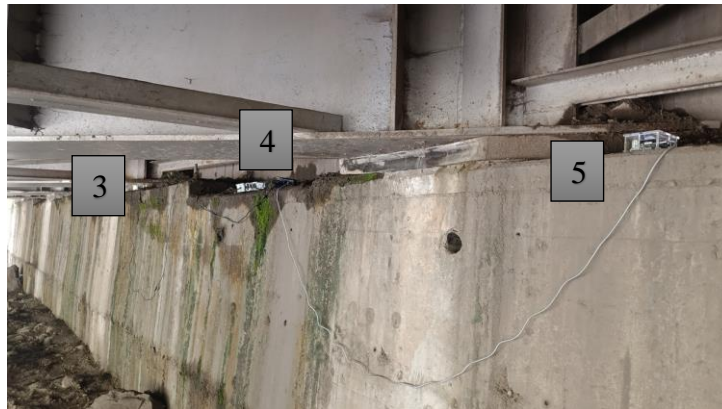
Ilustración 12 Equipo de vibración ambiental conectados en el estribo derecho
