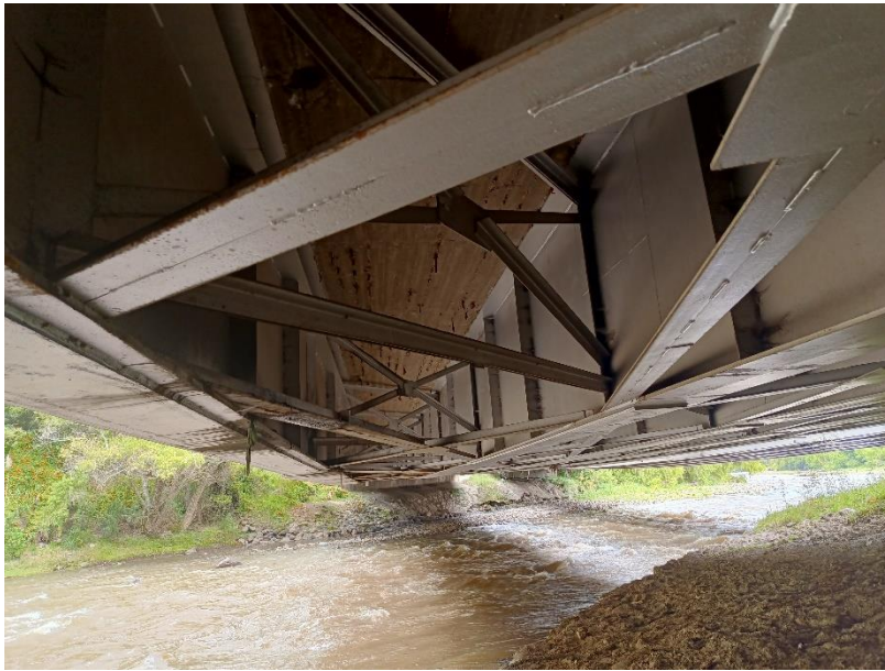
Ilustración 21 Armado inferior del puente
