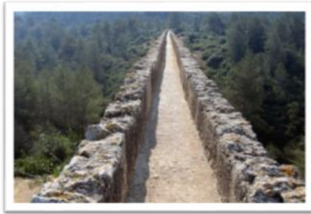
Imagen 1.1 Detalle de "Opus Signimun" canalizaciones hidráulicas
