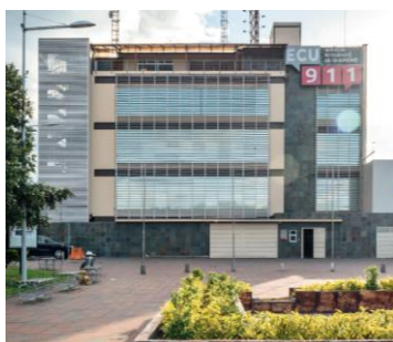
Figura 98: Edificio del Ecu 911
