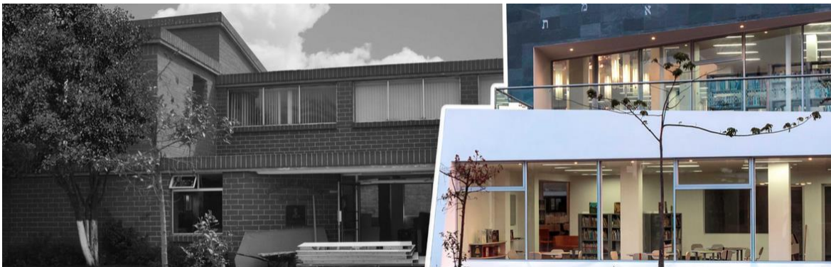
Figura 70: Remodelación de la antigua biblioteca
