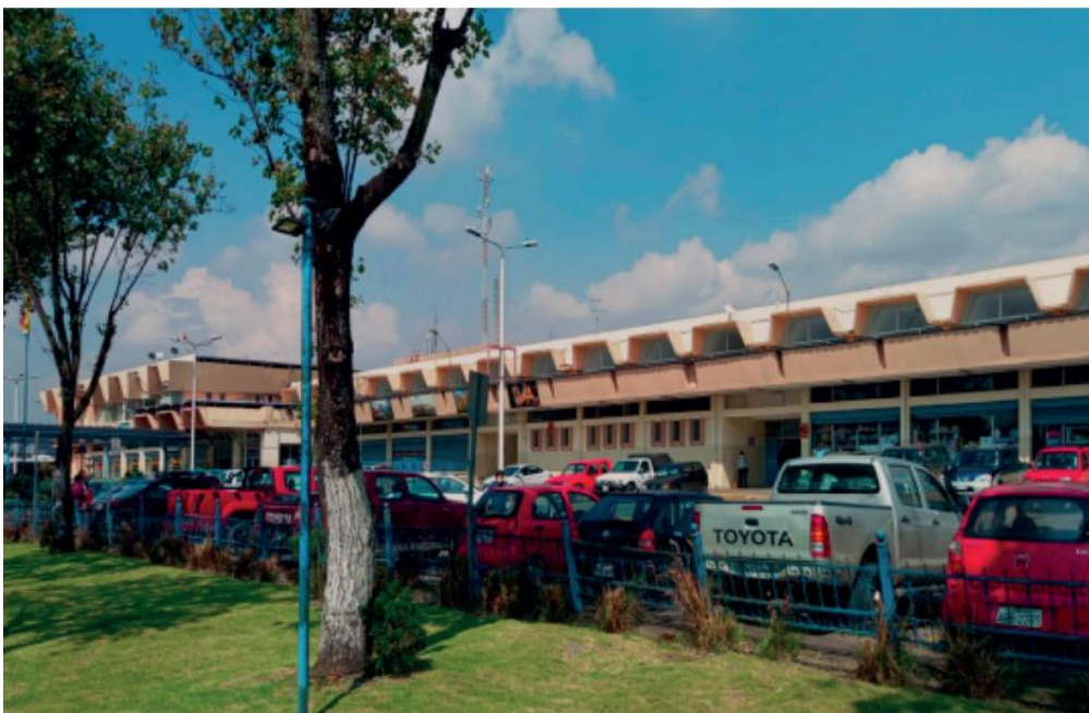
Figura 3.2: Fotografía del Actual Terminal Terrestre de Cuenca
