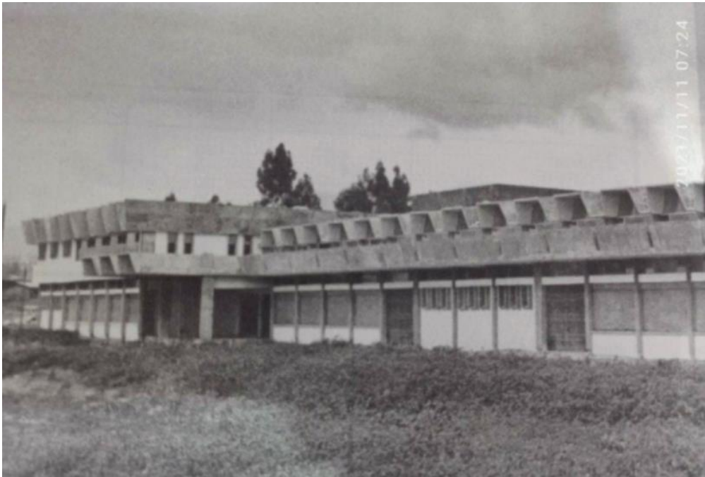
Figura 3.1: Fotografía del Antiguo Terminal Terrestre de Cuenca
