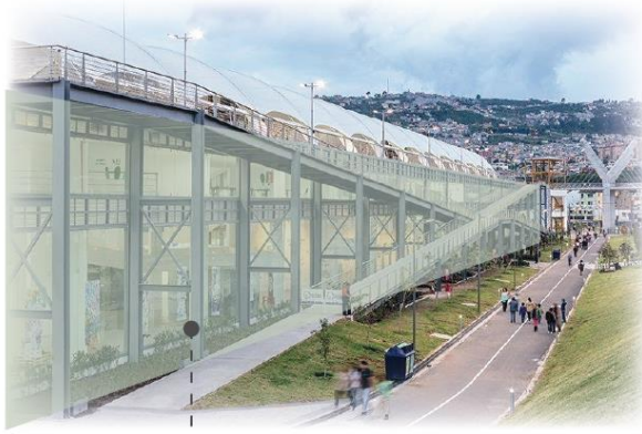
Implementación de cristal de piso a techo (espacio público)
