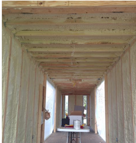
FIGURA 2.4: Aislamiento interior de contenedor marino con polieretano
