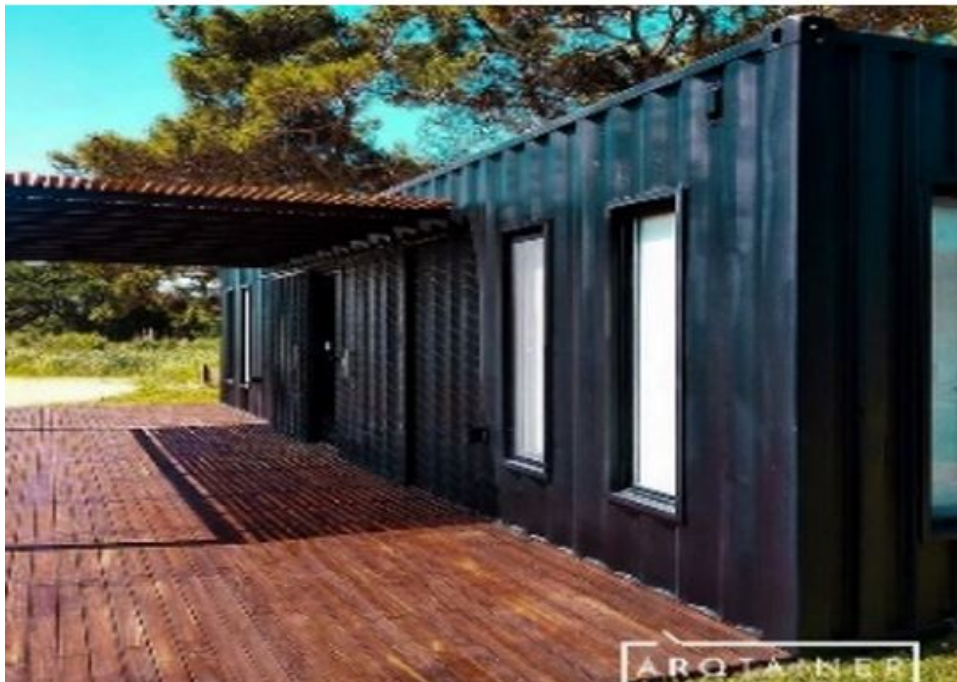
FIGURA 2.10: Fotos del proyecto La Patagonia construido
