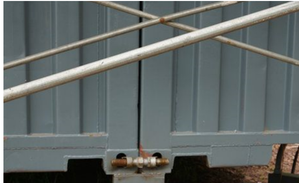
FIGURA 1.10 Abrazaderas entre contenedores
