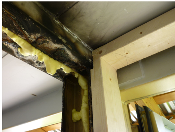
FIGURA 1.11: Sellado interior con poliuretano y
