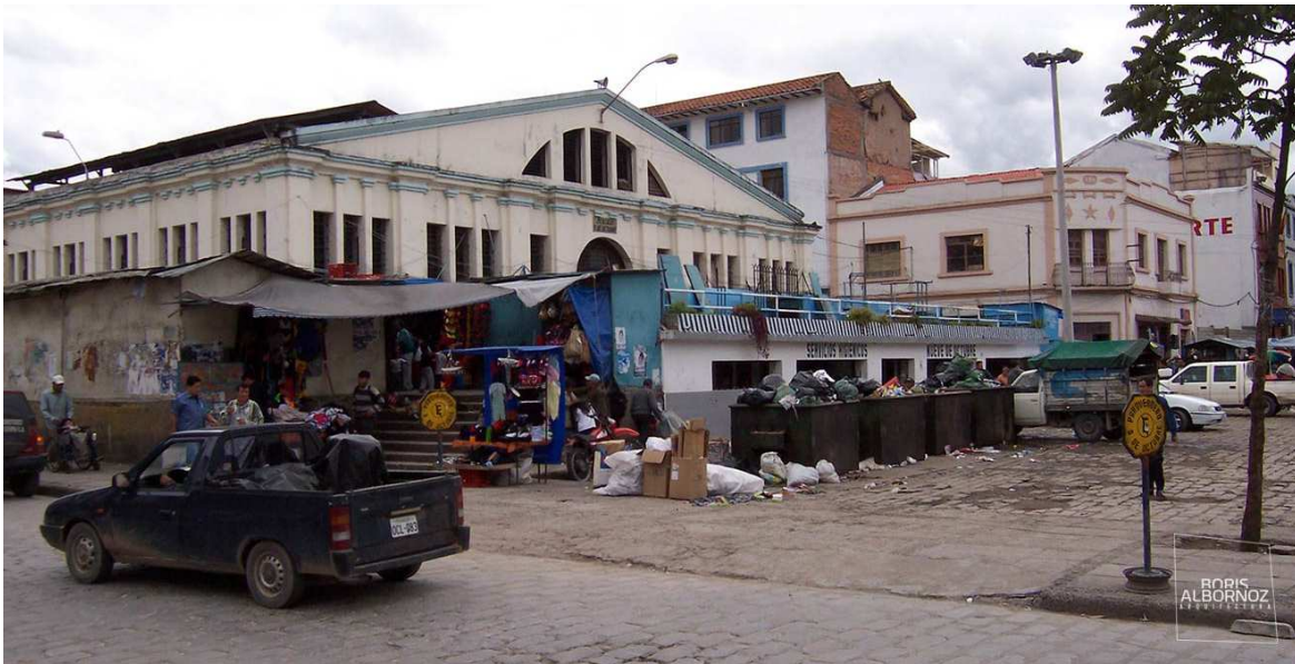
Figura 28: Mercado 9 de octubre antes de la regeneración
