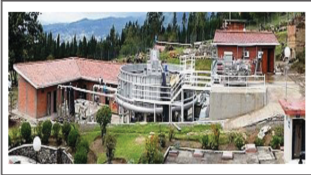
Foto. 86. Planta Potabilizadora de San Pedro- Proyecto Culebrillas.
