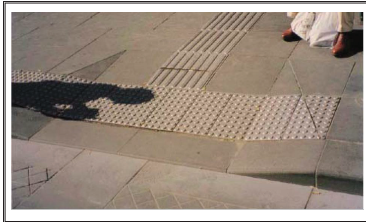
Foto. 88. Franjas Señalizadoras en rampas o vado.
