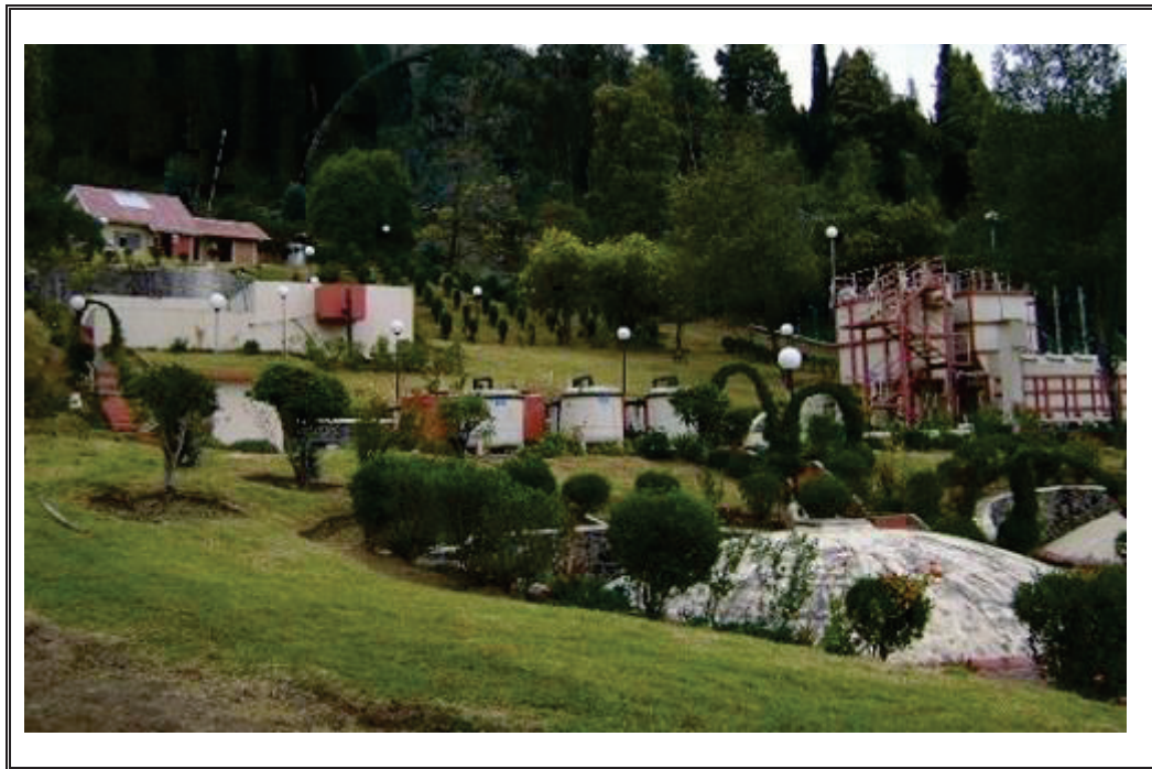
Fuente: http://www.etapa.net.ec/Productos-y-servicios/Agua-potable/Potabilizaci%C3%B3n/Plantas-urbanas Elaborado por Eduardo Cárdenas.
