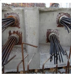
Figura 7: Uniones postensadas.
