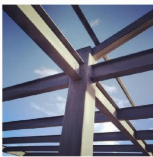
Figura 6: Uniones soldadas en acero
