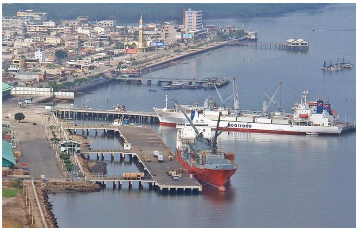
FIGURA 3.7: Fotografía aérea de Puerto Bolívar, Machala. Recuperado de Viajando x (2019).
