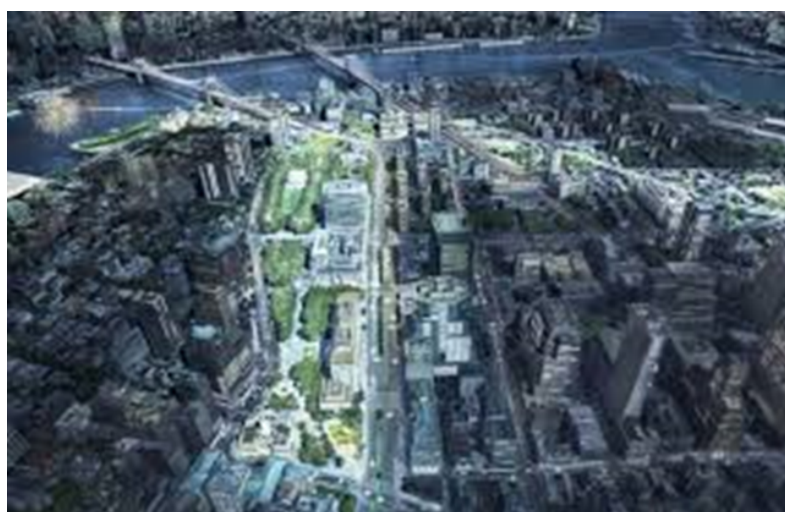
FIGURA 1.19: Espacio público ampliación de la ciudad. Fuente: jfpysociados (2021)
