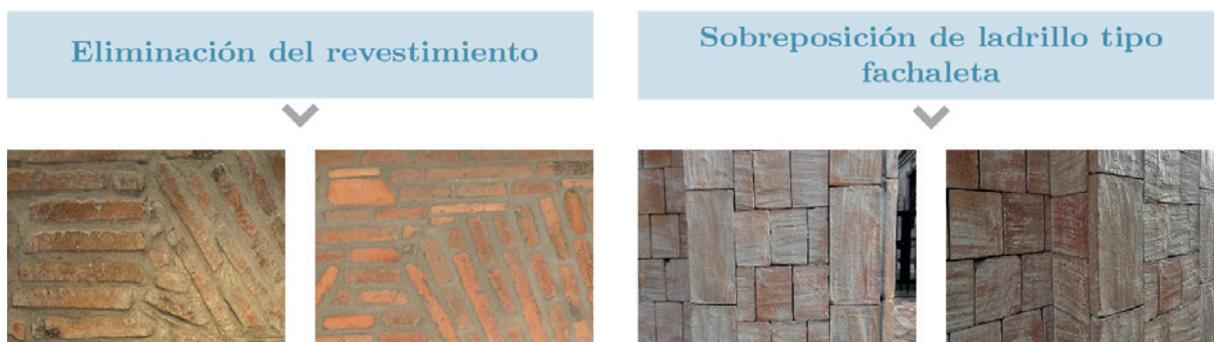
FIGURA 1.45: Aspecto de mampostería después de intervenciones realizadas en fachadas del CHC. Fuente y elaboración: Autora.
