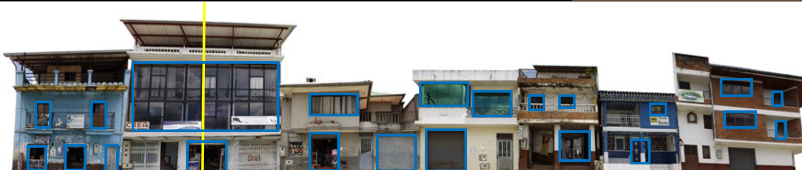
EDIFICACIÓN N1 EDIFICACIÓN N2 EDIFICACIÓN N3 EDIFICACIÓN N4 EDIFICACIÓN N5 EDIFICACIÓN N6 EDIFICACIÓN N7
