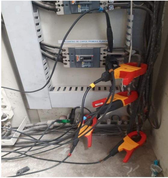
Figura 63 Instalación del equipo de calidad (FLUKE 434 Power Quality Analyzer) para medir la fiabilidad de la generación distribuida de la Unidad académica UCACUE. Fuente. Autores.
