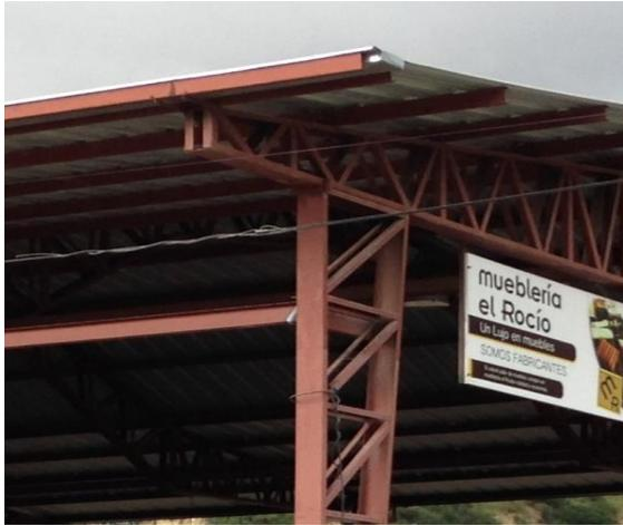
Los galpones que conforman el segundo y tercer ambiente se componen por cerchas metálicas construidas con perfiles tipo G que sostienen una cubierta de zinc a dos aguas con una canaleta encajada en la estructura, la que se extiende en sentido longitudinal al elemento que la contiene, y conduce las aguas lluvia directamente hacia el alcantarillado público; El contrapiso es de hormigón y está en buenas condiciones debido a la protección de la cubierta, evitando el deterioro por el agua.
