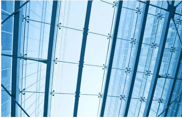
**Estructura.** Como concepto de muro - cortina podemos afirmar, que se trata de un elemento que estructuralmente tiene como única carga su propio peso, por lo que resulta factible para nuestro propósito el de no afectar la estructura de los galpones, dicho elemento se construirá a partir de tubos rectangulares que forman una retícula donde
