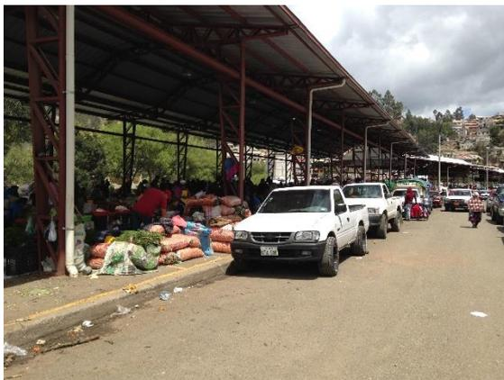
La estructura de acero se encuentra en buen estado, puesto que la pintura anticorrosiva de color rojo oxido empleada, ayuda a proteger el acero contra la humedad del ambiente, prolongando su vida útil, en tal razón, se ve conveniente reutilizar parte de estos elementos y adecuarlos a la propuesta que se planteará más adelante.
