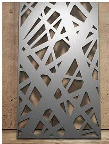
**Materiales.** Los materiales empleados para esta propuesta mantienen relación con la primera, con la diferencia de que para lograr esta fachada se usan módulos en plancha metálica negra de 1cm de espesor con el respectivo diseño con corte en plasma.
