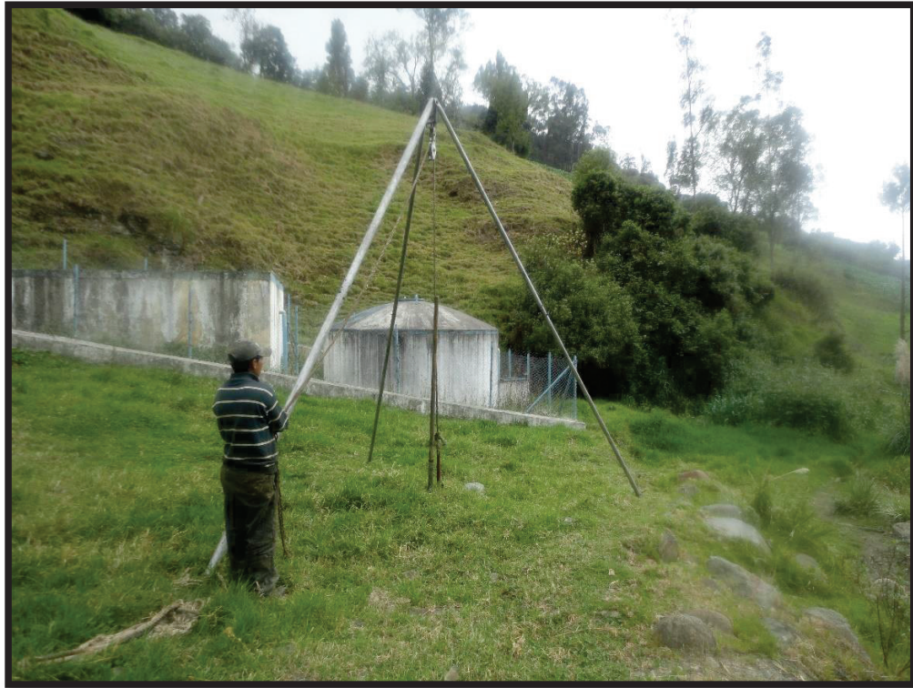
Perforación Pozo N° 2
