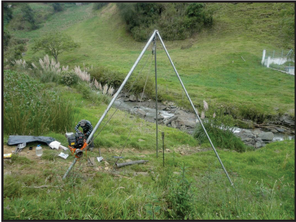
Perforación Pozo N° 1
