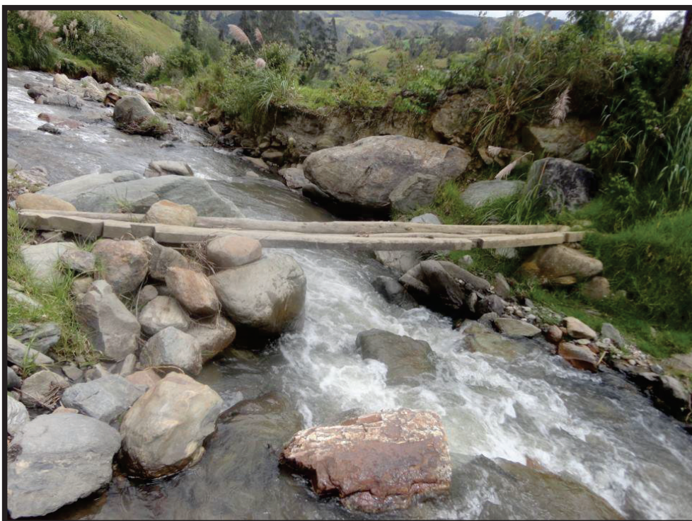
Puente existente en la zona de implantación
