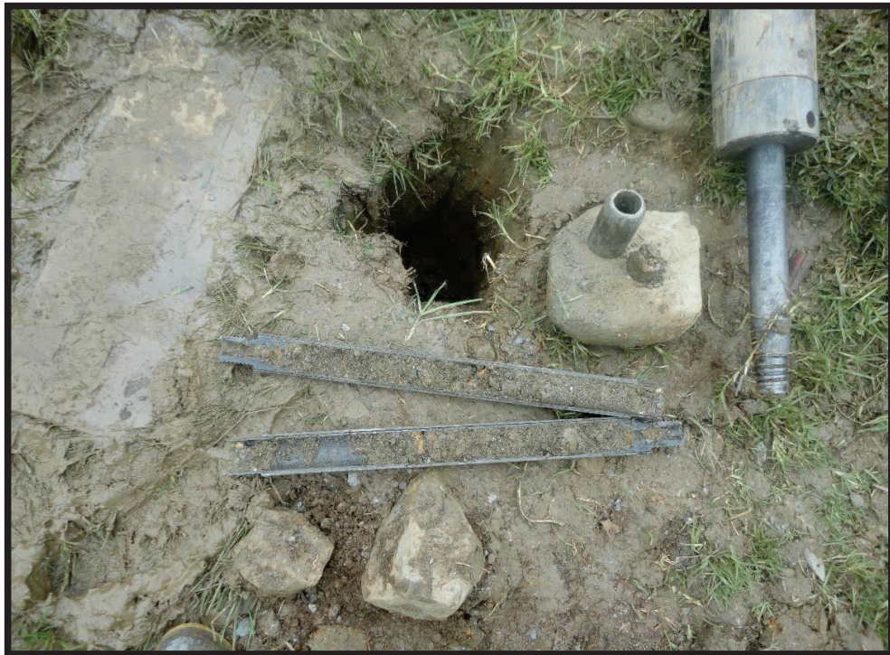
Perforación Pozo N° 2
