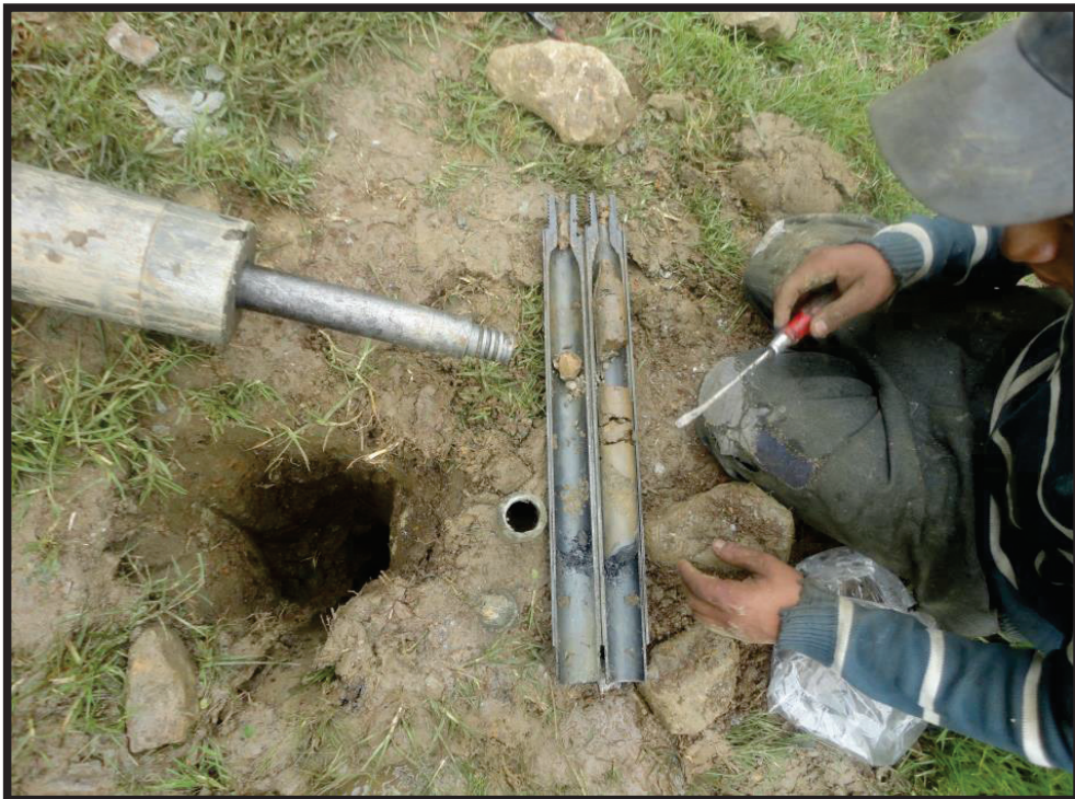
Perforación Pozo N° 1
