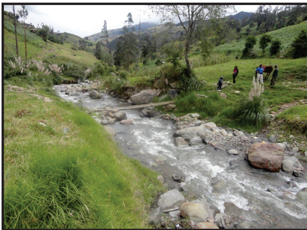
Inspección del lugar a implantar con la presencia del Sr. Rigoberto Borja, Presidente de la Junta Parroquial de San Vicente, perteneciente al Cantón El Pan, Provincia del Azuay.
