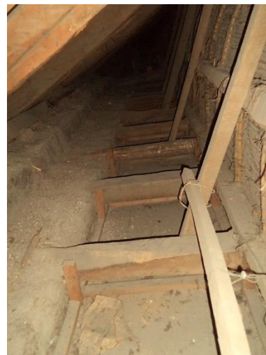
Fig. 43. Estructura lateral de cubierta
