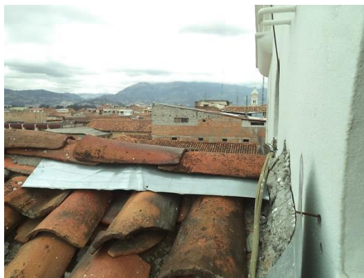
Fig. 45. Estado actual de cubierta
