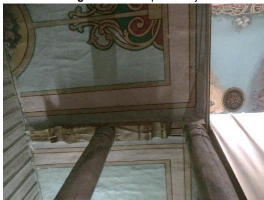
Fig. 35. Pilastras planta baja
