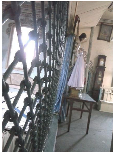
Fig. 54. Herrería deformada
