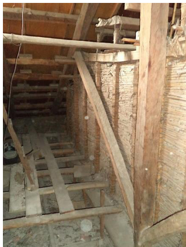
Fig. 42. Estructura frontal de cubierta
