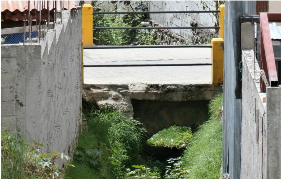
Fotografía 13. Puentes Que Son Construidos Sin Tener En Cuenta Una Sección Útil.
