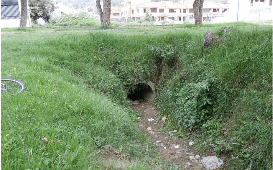
Fotografía 5. Sección de tubería reducida por acumulación de Sedimentos.
