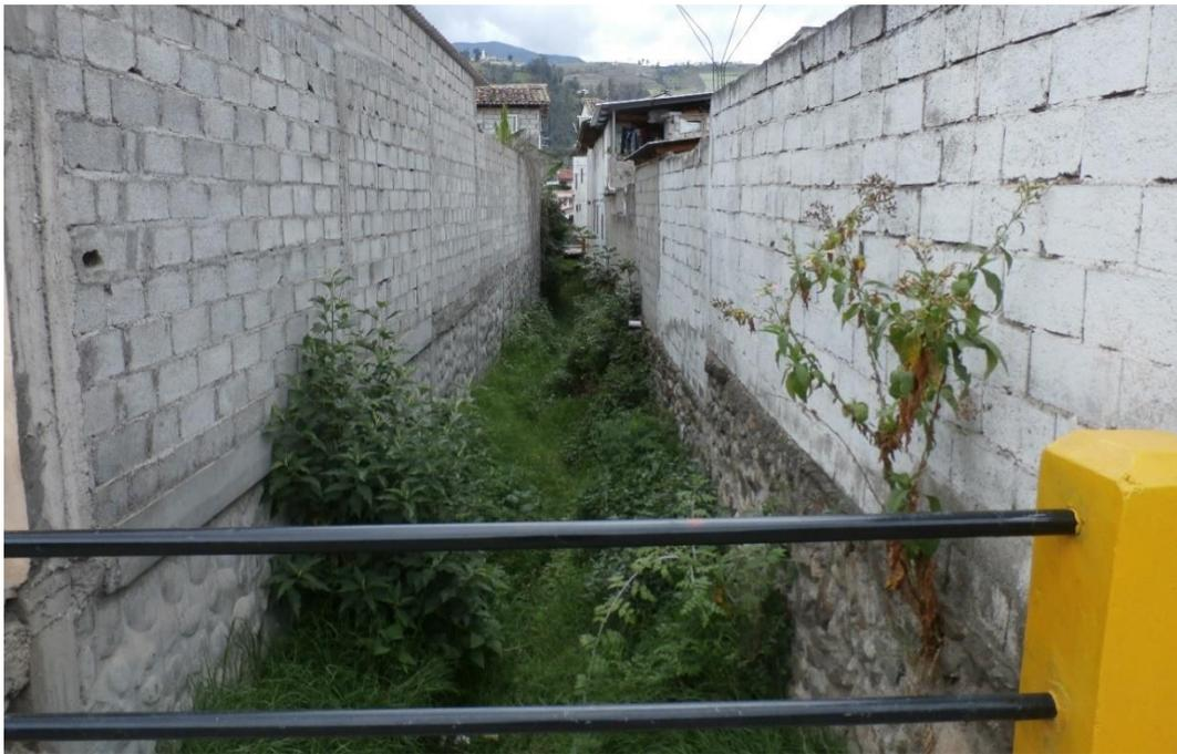
Fotografía 11. Las Quebradas Por Falta De Mantenimiento Pierden Su Sección Por Causa De Arbustos Que Crecen En Su Cauce.
