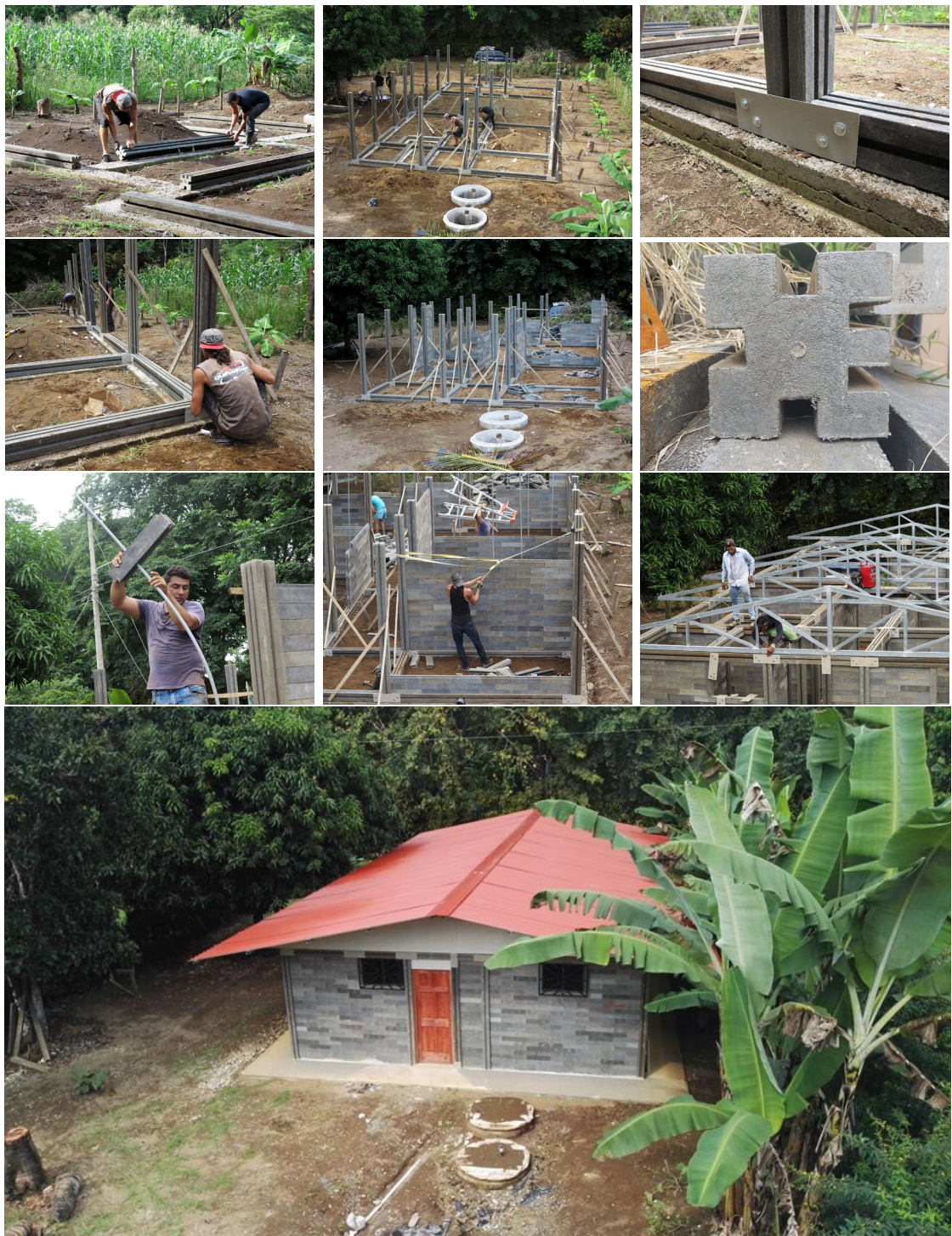
FIGURA 1.4: Proceso constructivo de una vivienda con el sistema de Bloqueplas, Fuente: https://www.facebook.com/pg/ekojunto/photos/?ref=page_internal
