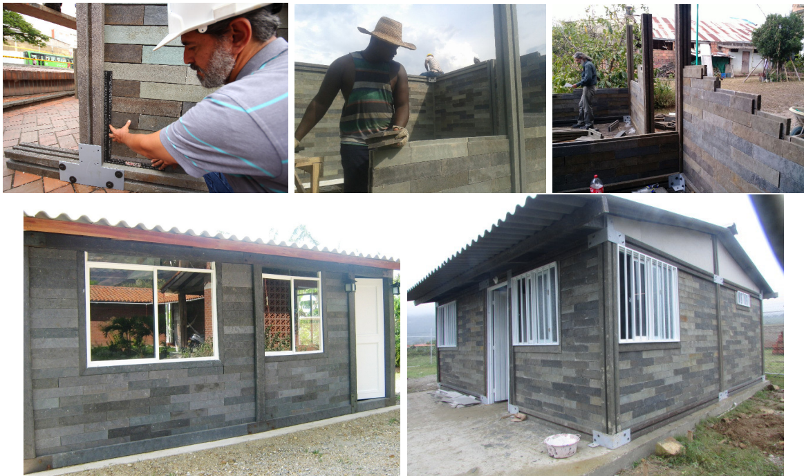
FIGURA 1.6: Proceso constructivo utilizado para anclar los bloques PET de la empresa Conceptos Plásticos., Fuente: https://www.facebook.com/pg/conceptosplasticos/photos/?ref=page_internal
