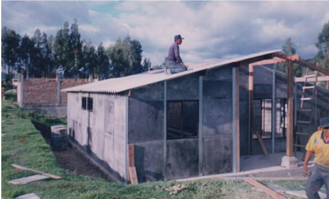
Fotografía 7.- Armado de estructura de madera y placas de ferrocemento en cubierta.
