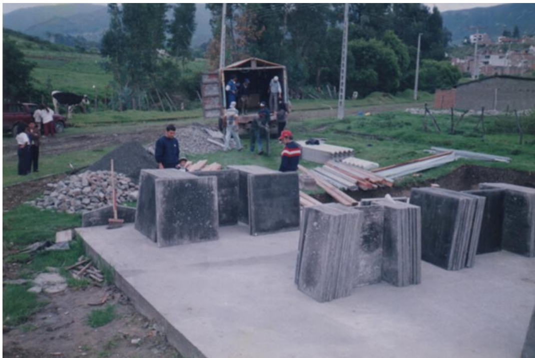
Fotografía 2.- Descarga de módulos de hormigón, perfiles de galvalúmen y vigas de madera en plataforma.
