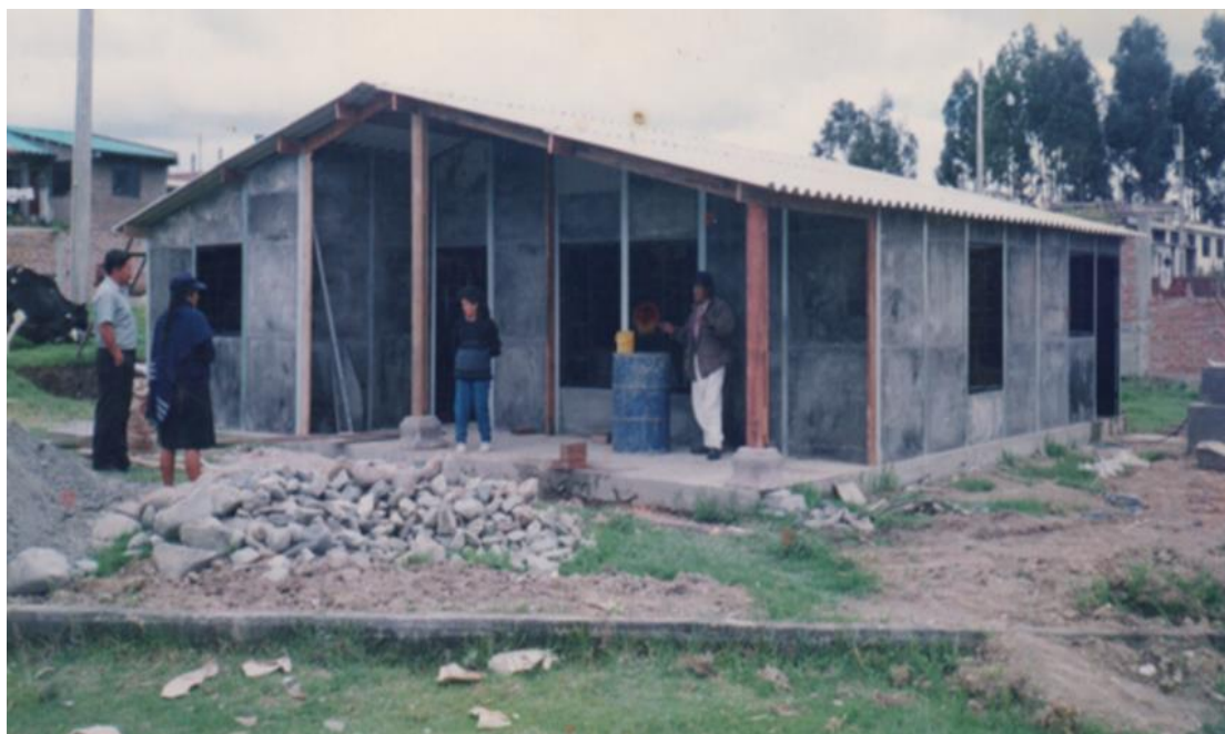
Fotografía 9.- Casa prefabricada terminada de armar.
