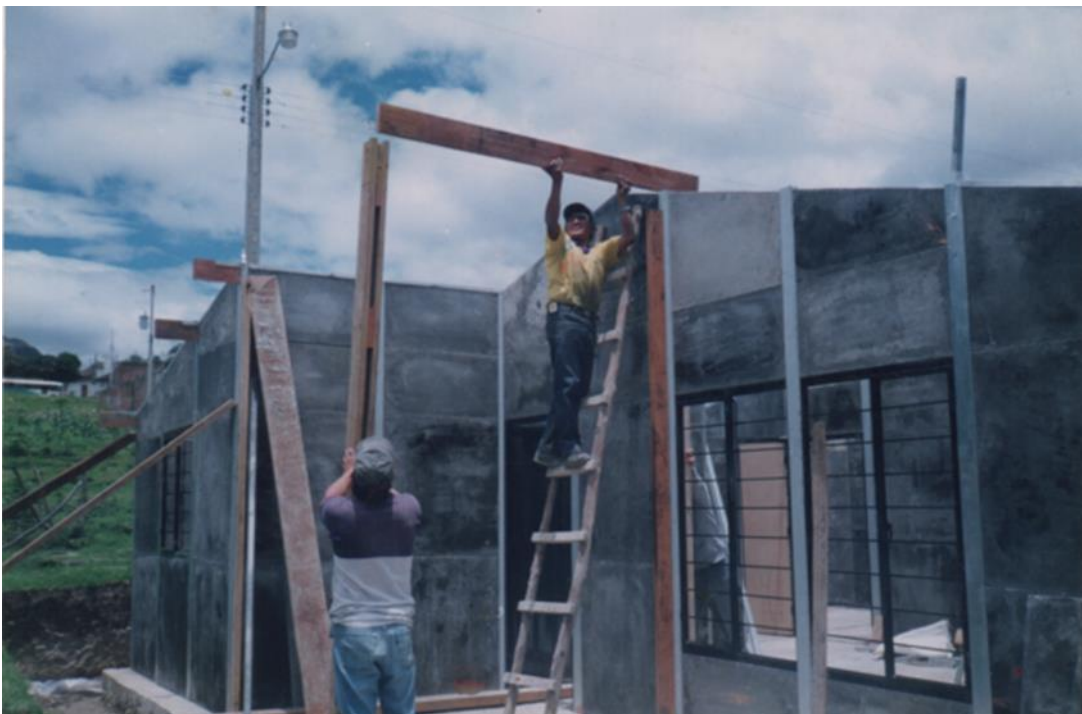
Fotografía 6.- Armado de estructura de madera en cubierta. Área de acceso.
