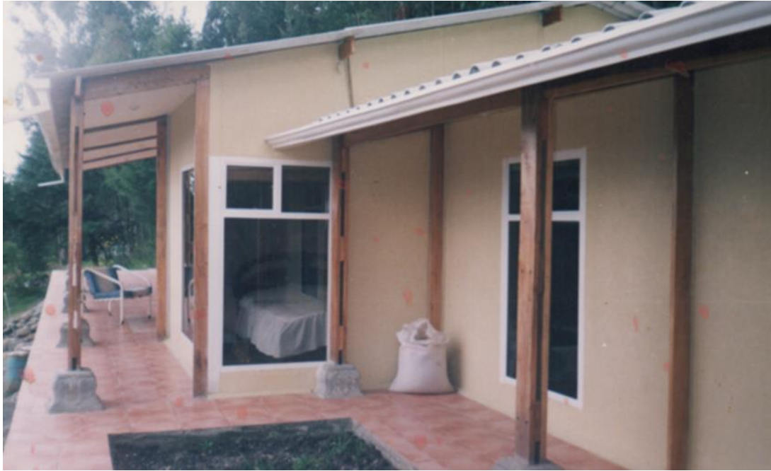
Fotografía 3.- Vivienda tipo de 48 m2. Con acabados exteriores
