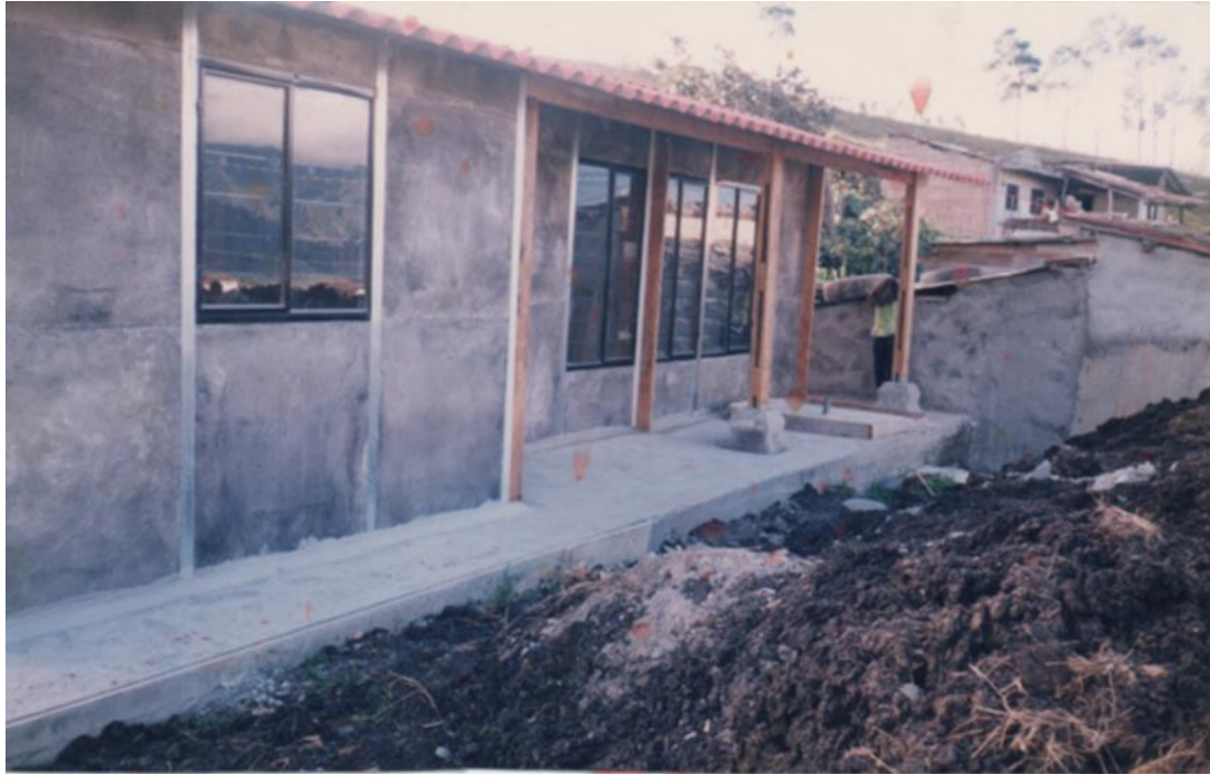
Fotografía 1.- Vivienda tipo de 48 m2. Sin acabados exteriores.
