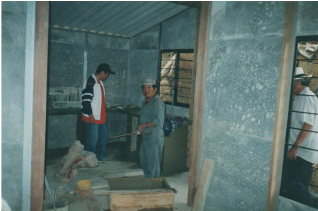
Fotografía 2.- Vivienda tipo de 48 m2. Sin acabados interiores.
