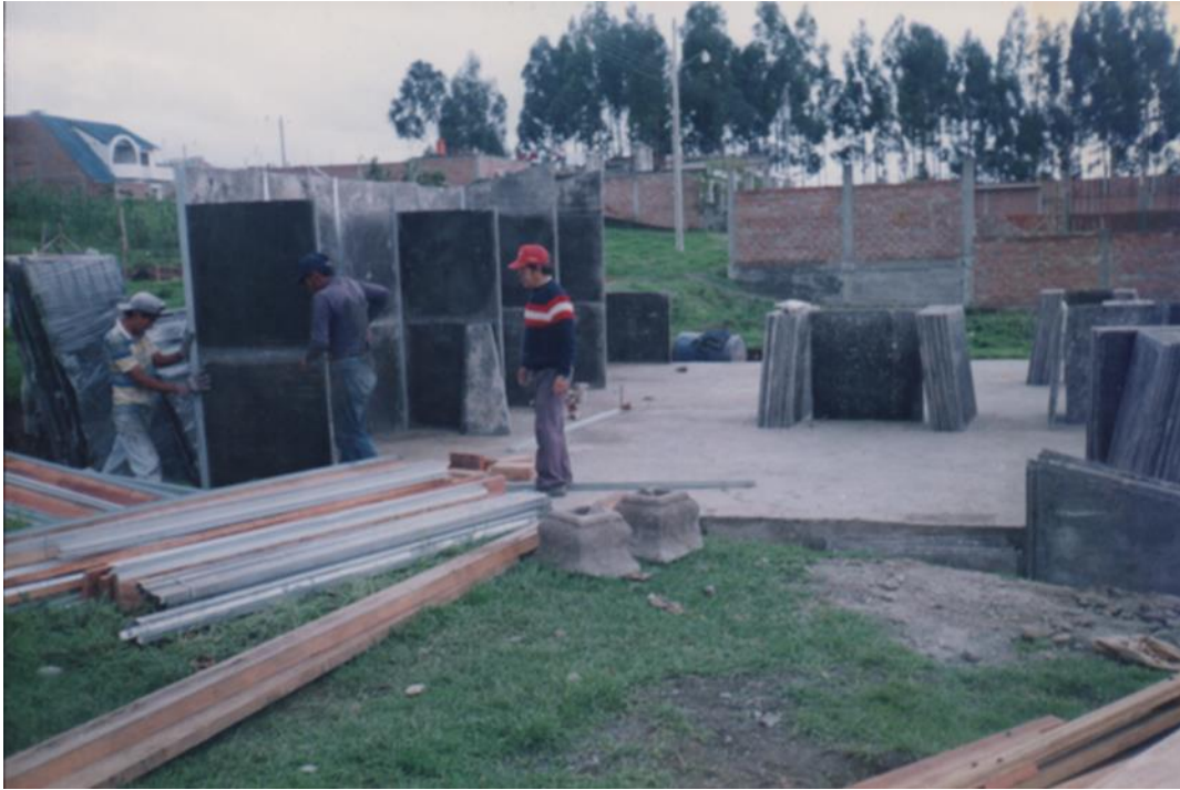
Fotografía 3.- Armado de módulos de hormigón sobre plataforma. Área de dormitorios.
