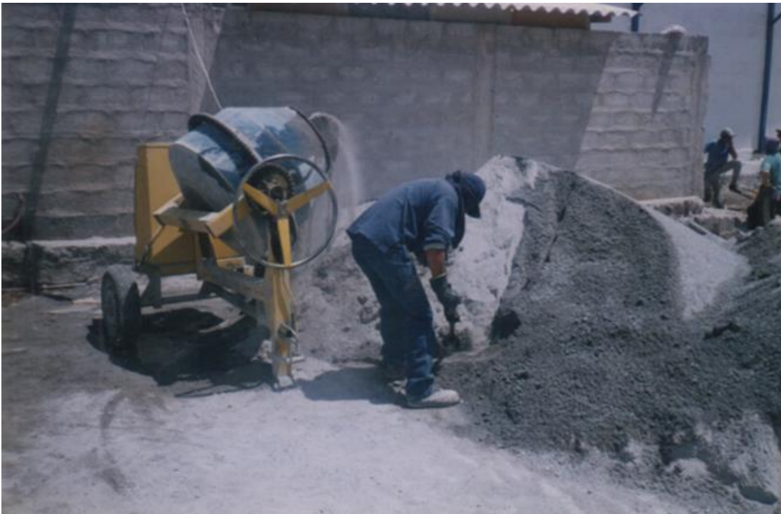
Fotografía 4.- Preparación de la pasta para la fabricación de los paneles de hormigón.
