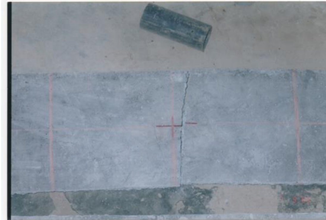
Fotografía 3 y 4.- Tipos de falla en paneles de hormigón a flexión.
