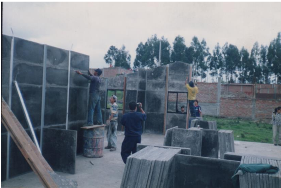
Fotografía 4.- Armado de módulos de hormigón sobre plataforma. Área social.
