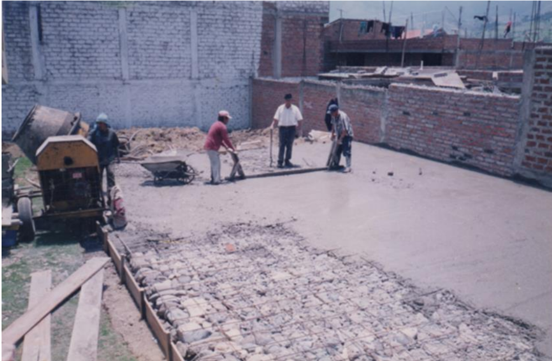
Fotografía 1.- Contrapiso (plataforma) de Ho. Armado
