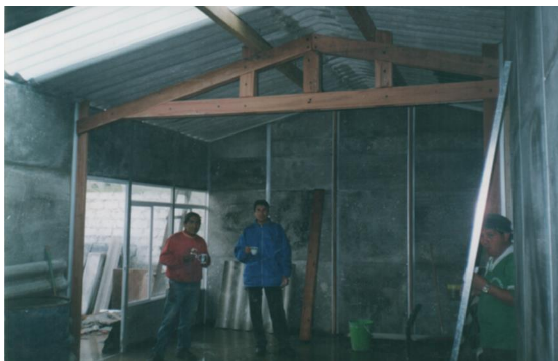
Fotografía 10.- Casa prefabricada terminada de armar.
