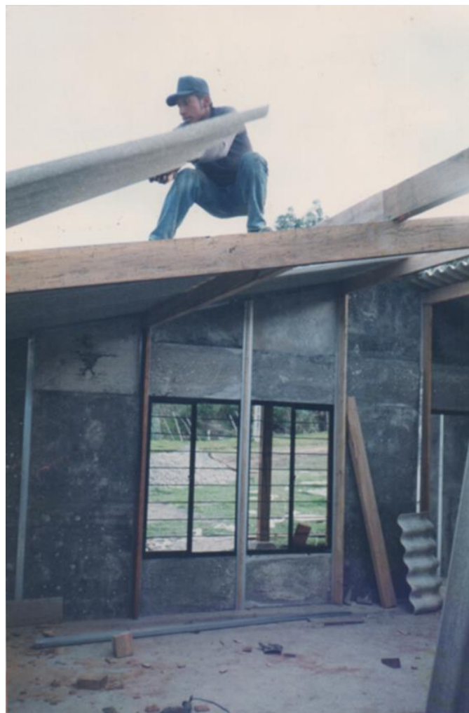
Fotografía 8.- Armado de cubierta de ferrocemento.
