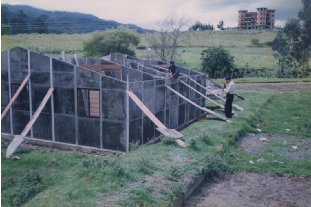
Fotografía 5.- Armado de módulos de hormigón en paredes perimetrales
