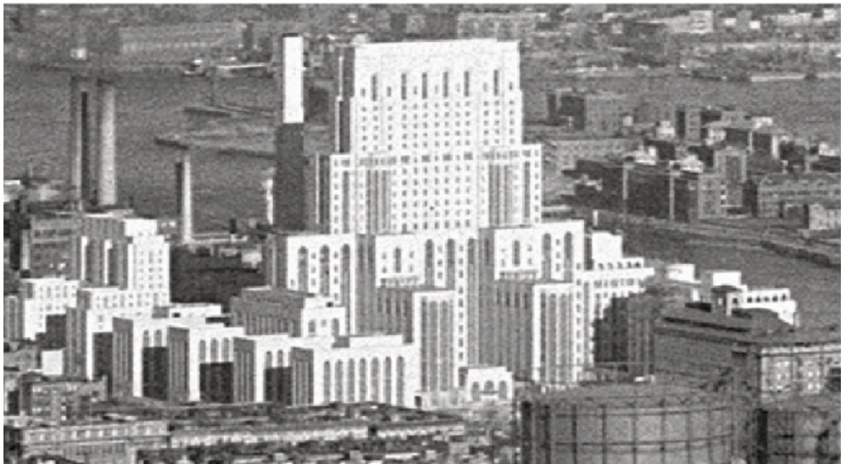
FIGURA 1.10: Hospital Cornell Medical Center (1932), Nueva York. Fuente: Perdiguero, E. (2012)
