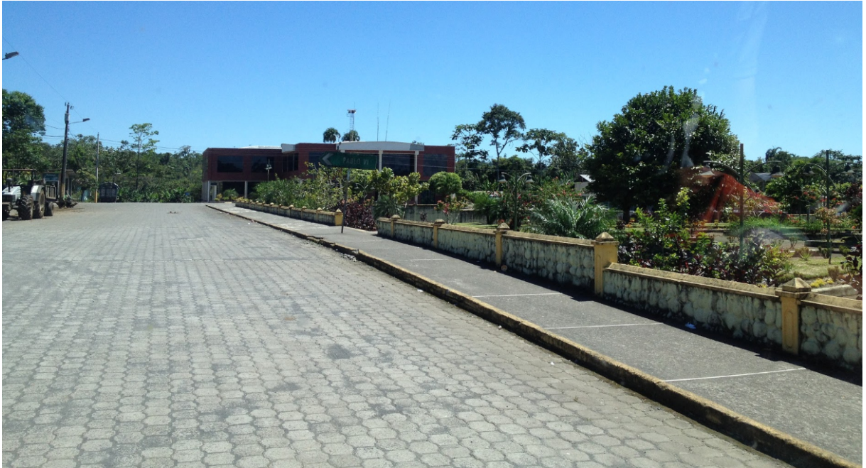
IMAGEN 6.6: Vía lateral al parque central (RCH, 2013)
