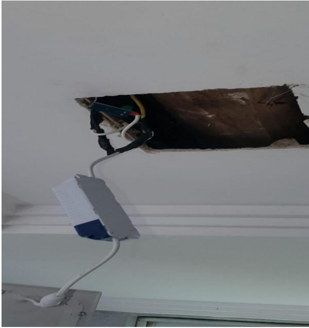
Colocacion de sensores en habitacion master
