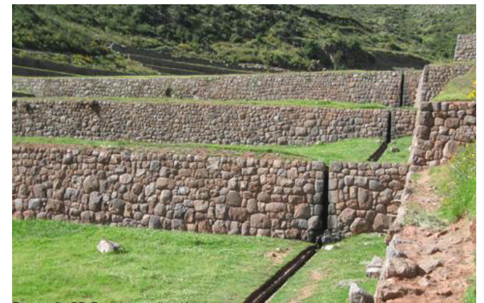
Fotografía 36: Red de canalización de agua. Fuente: http://www.unc.edu/~hdefays/courses/span330/arte/incas-tipon6.jpg
