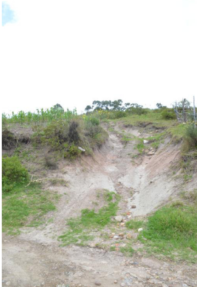
Fotografía 11: Escorrentía en la Loma Yanacauri (Cuenca-Ecuador). Fuente: Propia
