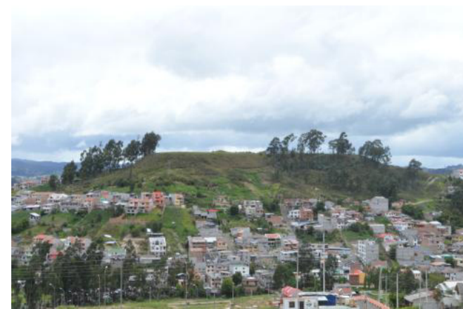
Fotografía 61: Frente norte Loma Yanacauri (Cuenca-Ecuador). Fuente: Propia
