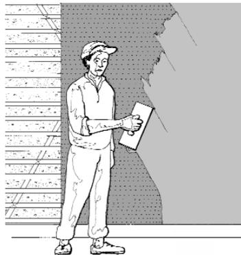
**Ilustración 48 Afinado superficie del muro Bahareque**
