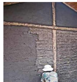
**Imagen 80** Colocación del revoque
