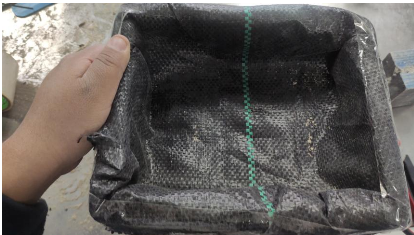
Figura 6: Segunda capa geotextil
