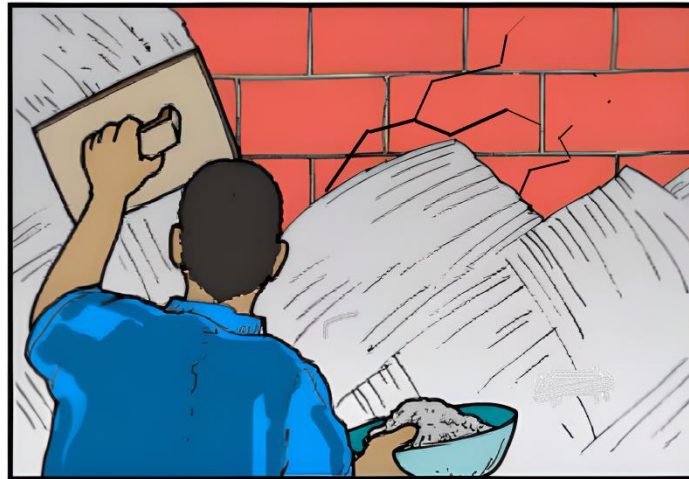
Figura 20. Forma de aplicación de la mezcla de concreto o mortero con fibras de reparación.
