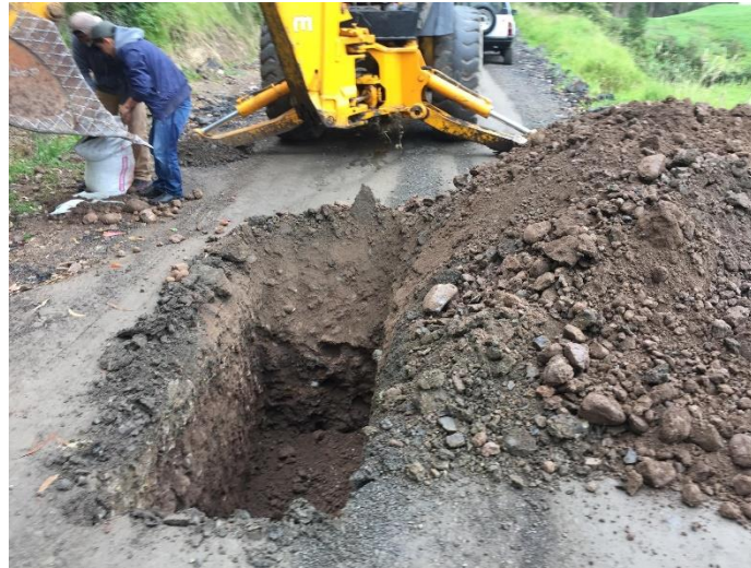
Figura 18: Extracción Calicatas.
