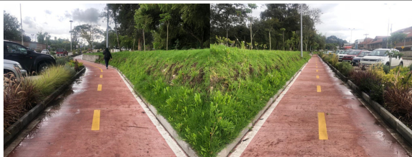
Segregada Avenida 10 de Agosto
