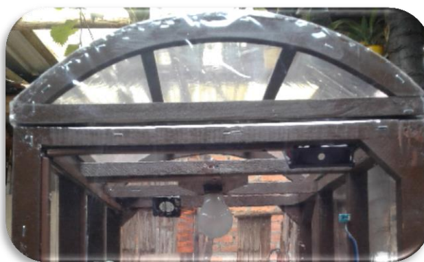
Figura 3.77 Vista del sistema de ventilación y fuente de calor Autor ().
