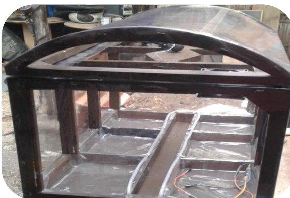
Figura 3.71 Instalación de las láminas de mica en la estructura a escala del invernadero Autor ().
