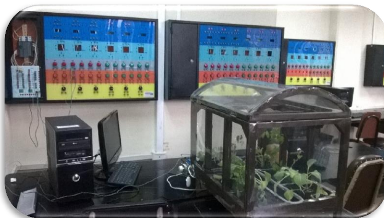
Figura D.3 Vista general del sistema SCADA OPC UA Ignition instalado con el invernadero en el laboratorio Autor ().
