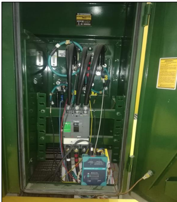
Fotografía 10. Vista general de instalación de equipo de análisis MEMOBOX 300 Fuente: (Salinas Quezada, 2019)
