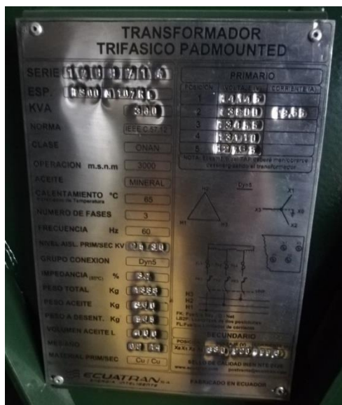
Fotografía 8. Placa T4 300 KVA y voltajes vistos en Tablero D3-1:TP_EE/RM/TM, energizado a través de transformador 4
