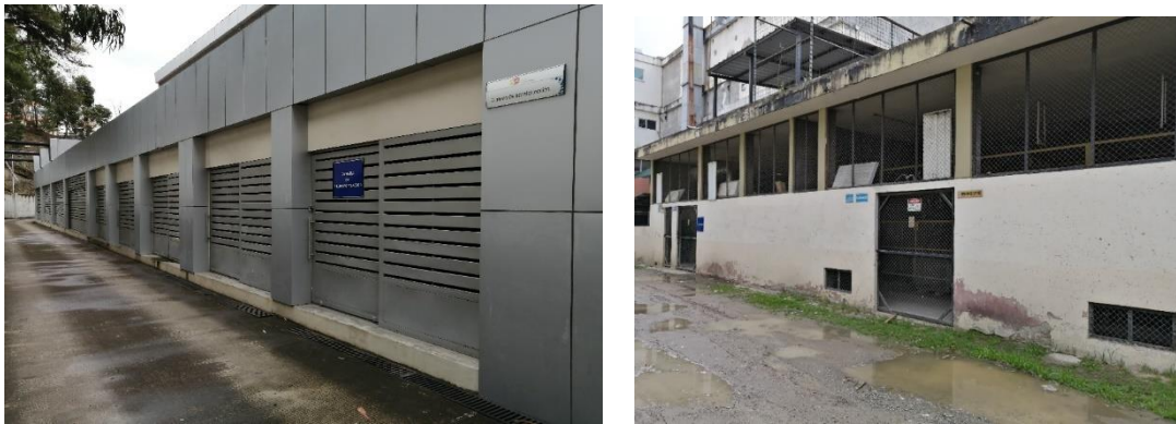
Fotografía 1. Vista de cámara de transformación 1 - área repotenciada y cámara de transformación existente 178136.
