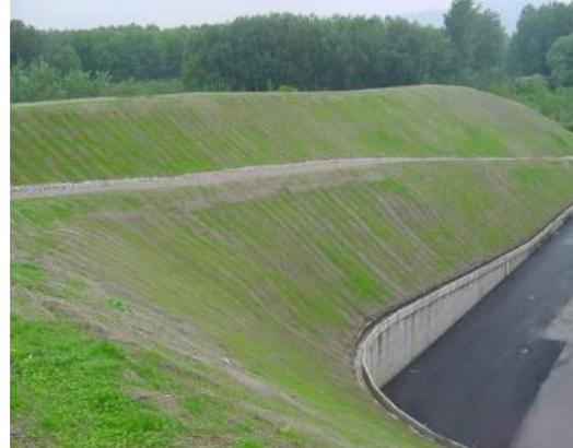
*Fig 29-30 Recubrimiento con la Biomanta*
