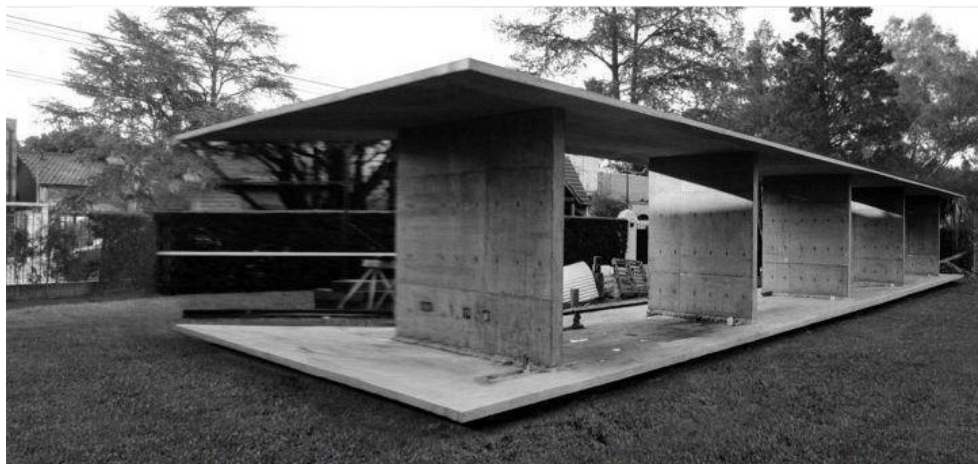
Figura 25: Estructura del Pabellón experimental del ladrillo
